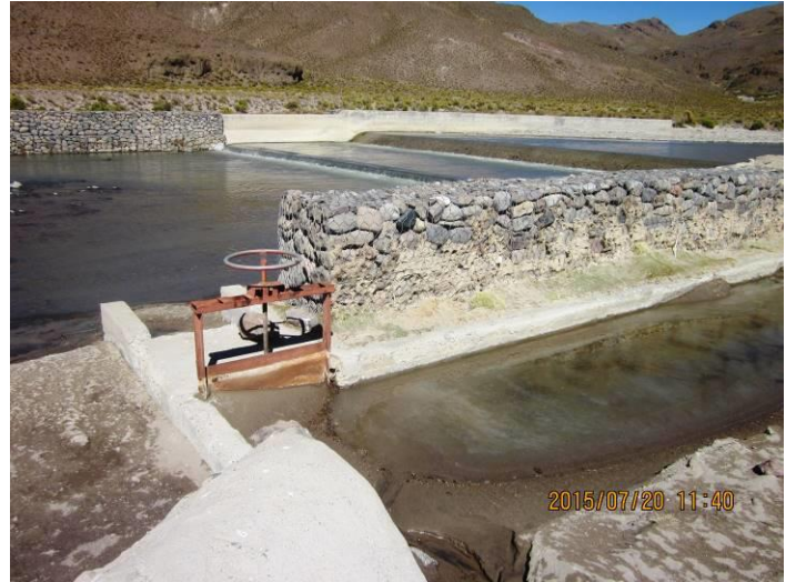
トゥルカ・マカヤの灌漑施設
