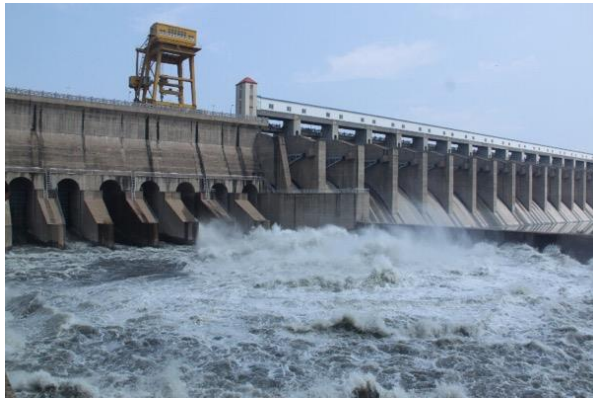
潘家口ダム外観
