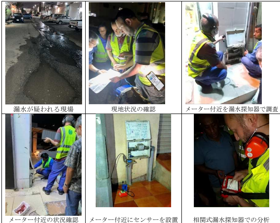
写真 3 JCBU の漏水調査状況
