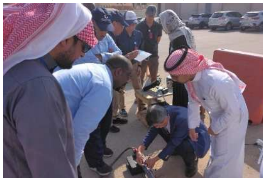
2022年12月15日RCBU 超音波流量計の説明
