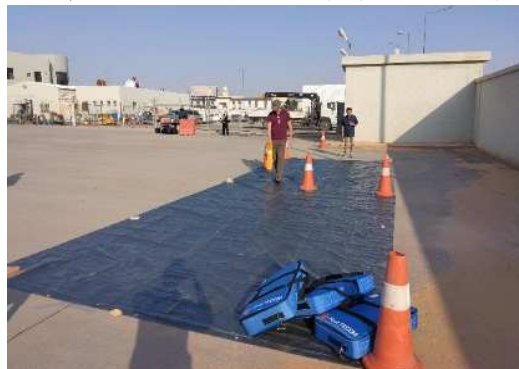
2022年12月15日RCBU ブルーシートで鉄線を覆い、金属管・ケーブル探知器を使用
