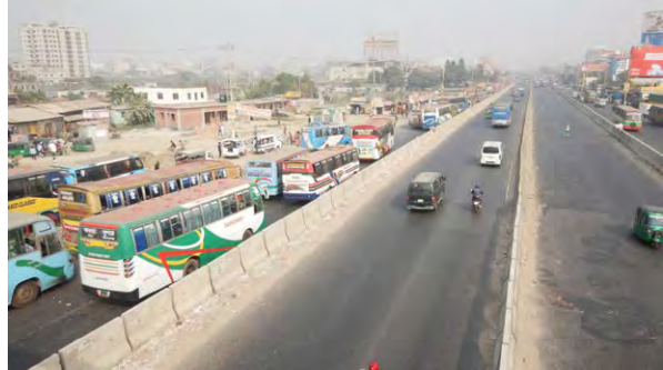
通過交通と地域内交通とが分離された交差点 SMVT レーンでの交通混雑は発生しているが通過交通レーンでは円滑な交通流が確保されている。
