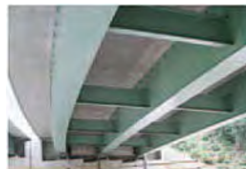
図 2.7.9 鋼細幅箱桁橋
