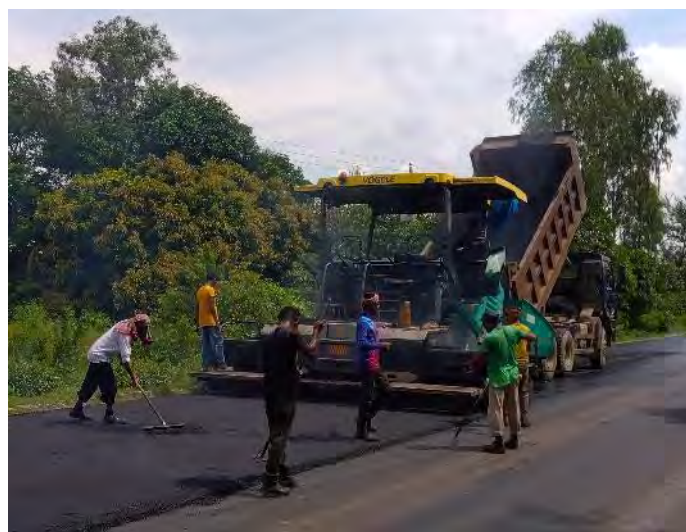
図 2.7.3 国道 1 号線でのオーバーレイ補修工事
