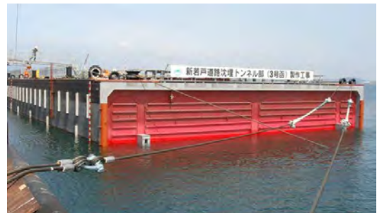
図 2.7.11 サンドイッチ式沈埋トンネル
