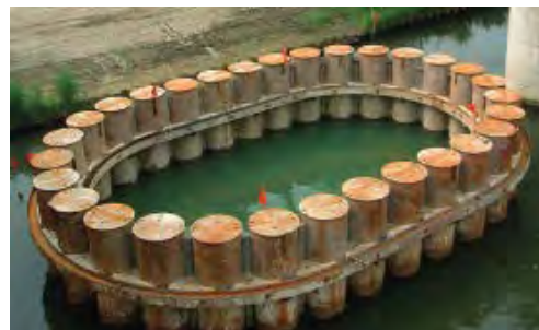
図 2.7.7 鋼管矢板井筒工法
