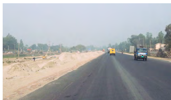
N4 (エレンガ-ジャムナ橋間) 工事中
