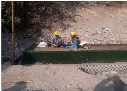
2段目(高さ1m) 締固め試験実施状況
