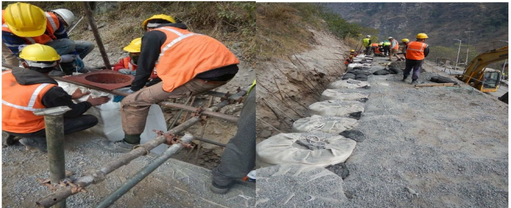
防護マット工
