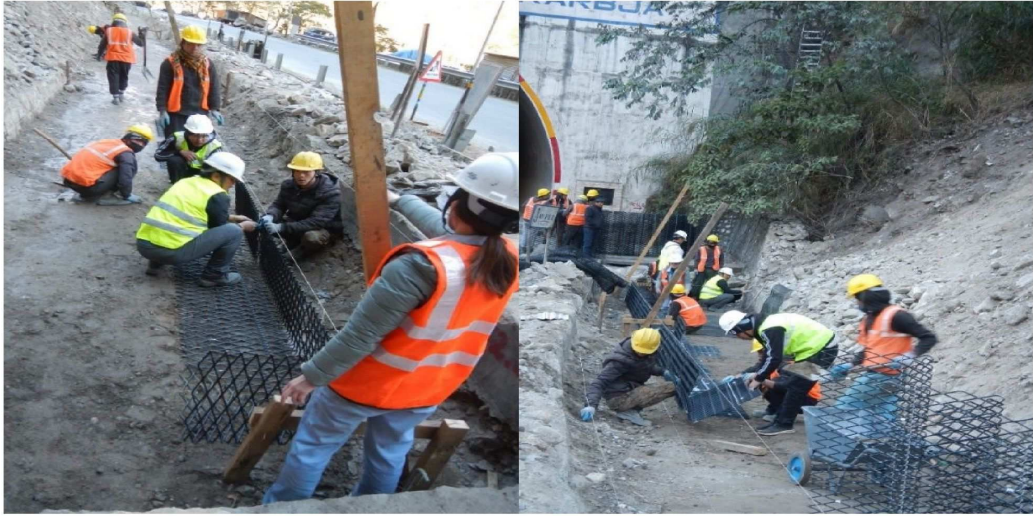
伝達体積上げ（施工現場から 50m 程度離れた空き地に仮置き）
