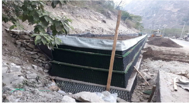
4段目中間層埋め戻し状況
