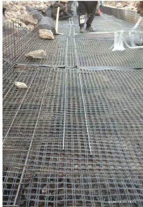
下段部ジオグリッドと上段部ジオグリッドの結合状況
