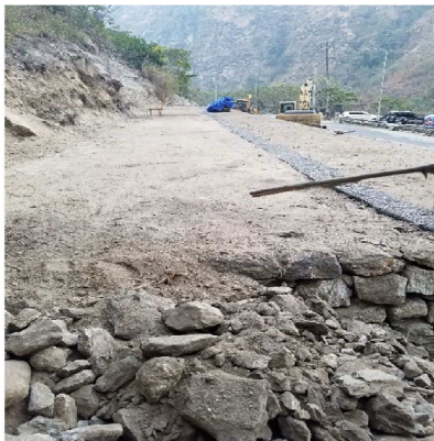
基礎部転圧完了写真(トンネル側から)1
