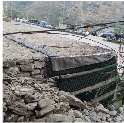
基礎部転圧完了写真(トンネル側から)2
