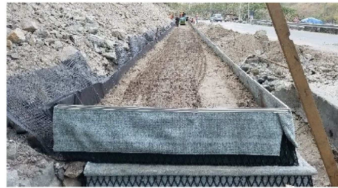
2段目中間まで埋め戻し、転圧
