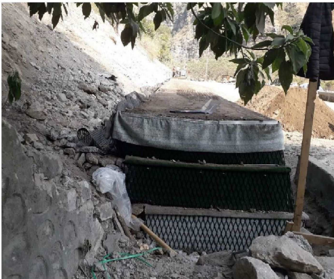
3段目埋め戻し完了
