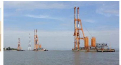
出典：五洋建設 CDM施工の様子（ラックフェン港）
