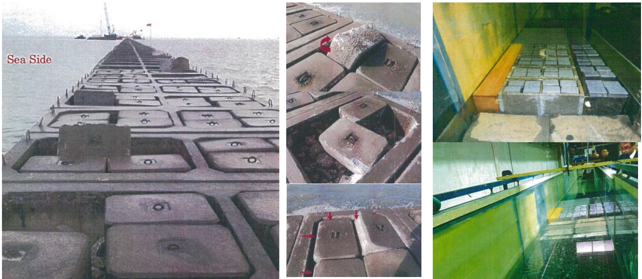
図 5 防砂堤の標準断面および据え付け状況
