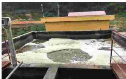
写真 35 曝気処理（第 1 曝気槽） （出典：調査団）
