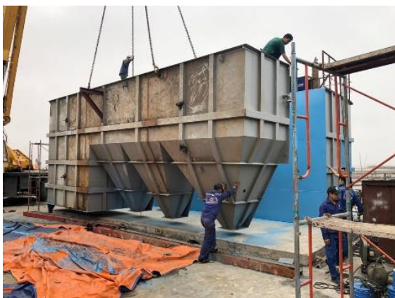
写真 15 沈殿槽据付状況 (出典：調査団)
