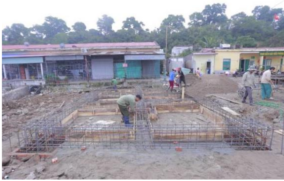
写真 11 基礎工事施工状況 (出典：調査団)
