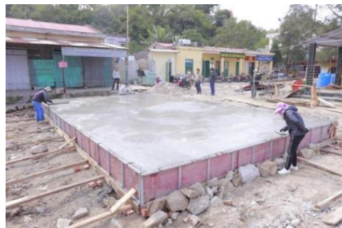
*コンクリート打設 (2020年2月)
