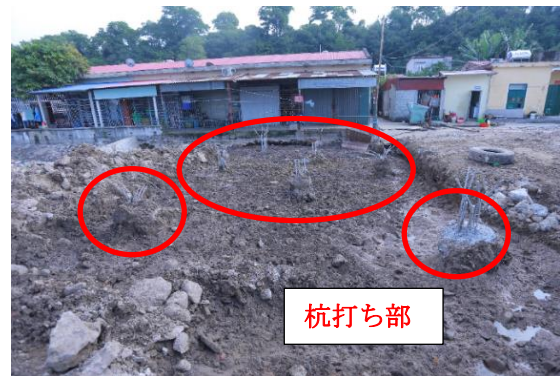
*杭打ち完了（2019年12月）
