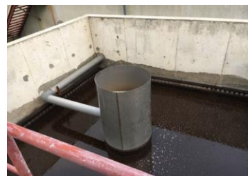
写真 36 第 2 沈殿槽（排水口直前槽） （出典：調査団）
