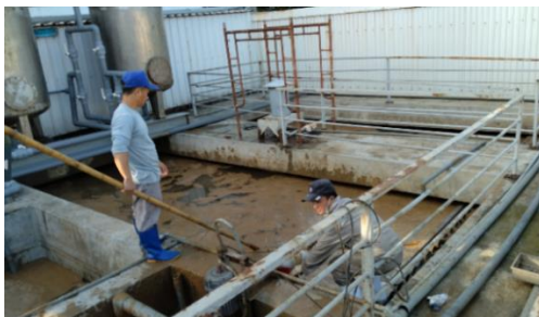
写真 41, 42 排水処理設備の処理状況 (出典：調査団) (多量の泡状浮遊物が発生しており処理状態は良くない)
