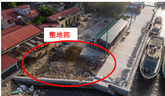
*設備設置用基礎部整地状況（2019年11月）
