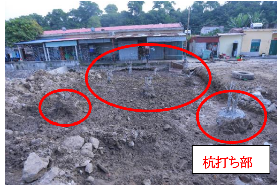
写真 10 杭打ち完了状況 (出典：調査団)
