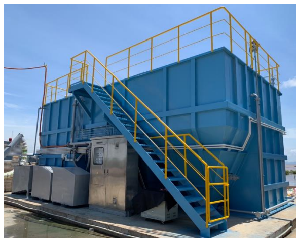
写真 20 CMシステム設備据付工事完了 (出典：調査団)
