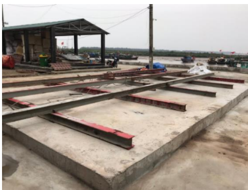
*基礎工事完了据付工事準備 (2020年3月)
