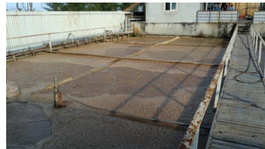
写真 41, 42 排水処理設備の処理状況 (出典：調査団) (多量の泡状浮遊物が発生しており処理状態は良くない)
