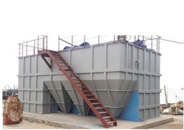
写真 16 処理槽据付・中塗り塗装工事完了 (出典：調査団)
