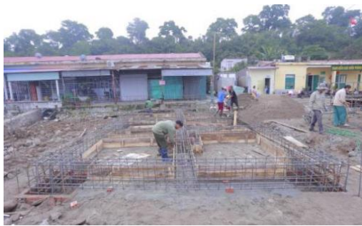
*鉄筋・型枠工事 (2020年2月)
