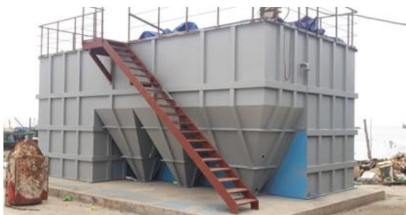
処理槽・沈殿槽据付、中塗り塗装完了 (2020年4月)
