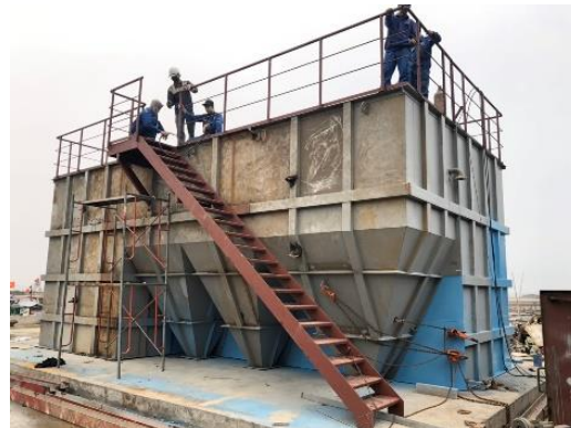
階段・手摺据付完了 (2020年3月)
