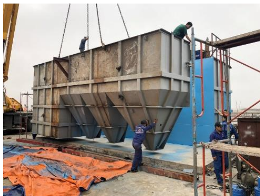
処理槽・沈殿槽据付工事状況 (2020年3月)
