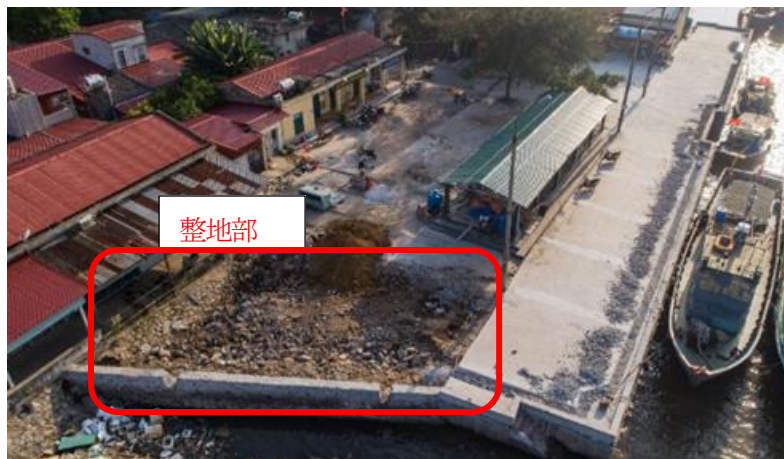
写真 2 実証設備設置場所整地工事 2019.11（出典：調査団）
