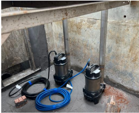
写真 17 調整槽水中ポンプ据付 (出典：調査団)
