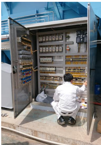
写真 19 制御・操作盤据付 (出典：調査団)
