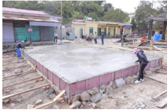
写真 12 コンクリート打設 (出典：調査団)
