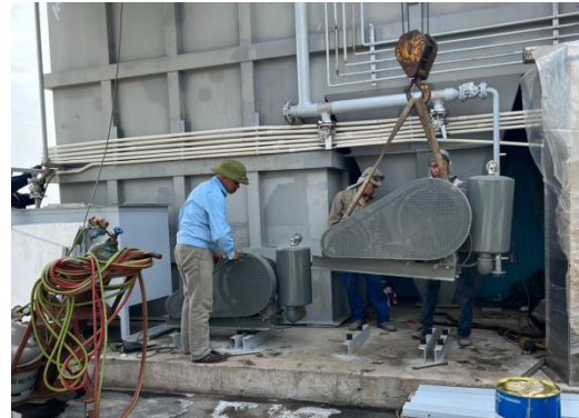
写真 18 ロータリーブロー据付 (出典：調査団)
