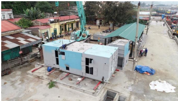
写真 13 処理槽の組立工事開始 (出典：調査団)
