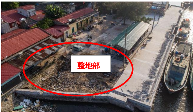
写真 9 設備設置用基礎部整地状況 (出典：調査団)
