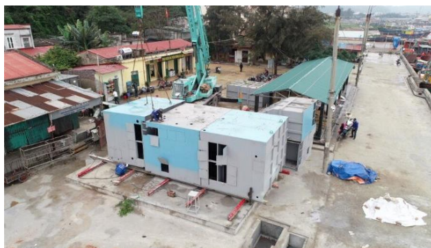
処理槽組立工事状況 (2020年3月)
