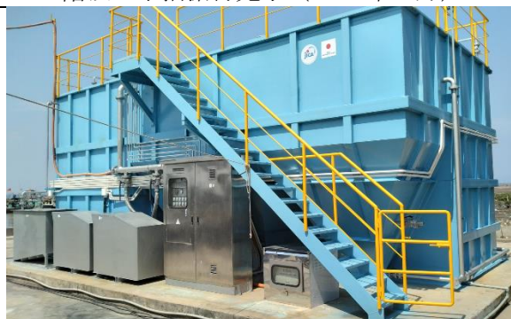
CMシステム据付工事完了 (2022年6月)
