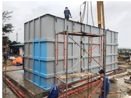
写真 14 処理槽据付状況 (出典：調査団)
