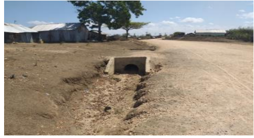
写真 3: 既設幹線道路の排水装置
