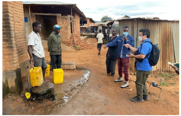
マーケットに唯一存在する公共水栓
