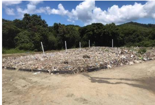
簡易埋立処分場 (ヤップ州の例)
