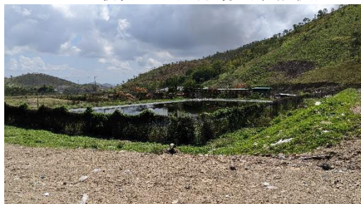
浸出水調整池
