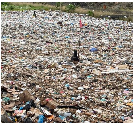
新規処分場の埋立状況 (覆土がされていない)
