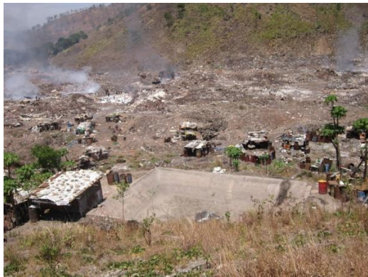
バルニ最終埋立処分場（改修前）
