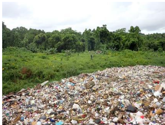
埋立完了した処分スペース (緑化部分) に 隣接した新規の処分場 (コスラエ州の例)
