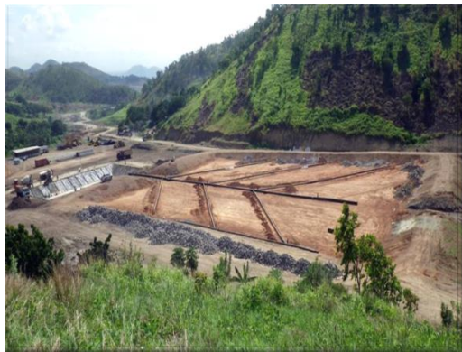
バルニ最終埋立処分場（改修後）
