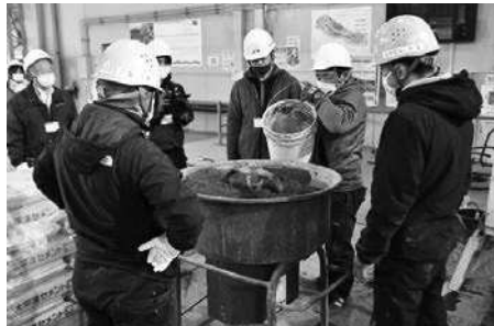
モルタル製作
