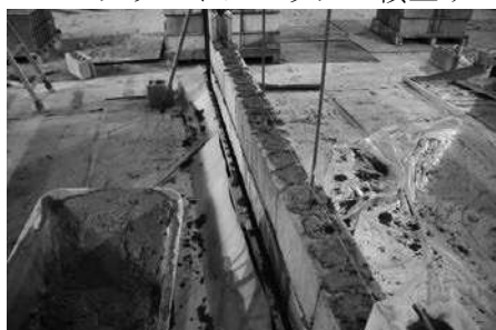
コンクリートブロック積上げ
