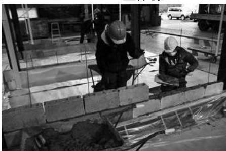
コンクリートブロックの積上げ
