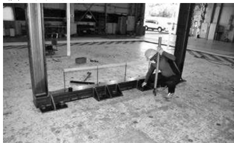
鉄骨フレームの据え付け
