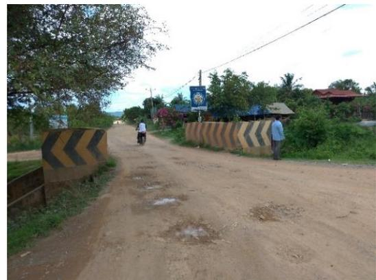
写真-16 写真-15と同じ地区内、水路と道路の交差点に安全塀（黒と黄）が2018年に設置された
