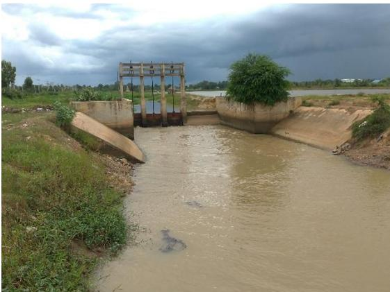
写真-21 写真-15と同じ地区内、州政府の予算で設計・施工されたが十分に機能を果たせていないとのこと
