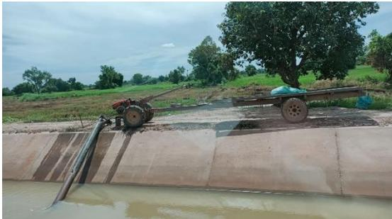
写真-3 写真-2と同じ地区での農民によるポンプ揚水。水路内水位が低いので重力灌漑は不可能
