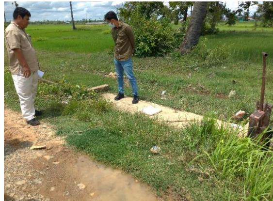
写真-20 写真-15と同じ地区内、3次水路をまたぐパイプカルバート。トラクターが通行するには十分な幅ではないとのこと
