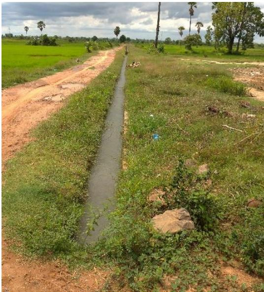
写真-19 写真-15と同じ地区内、JICA「灌漑技術センター計画フェーズ2」支援の3次水路（コンクリート製）。土水路は崩れやすいため、コンクリート水路の方が望ましいとのこと
