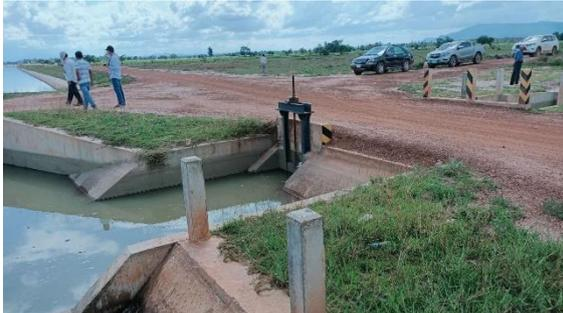
写真-11 円借款事業CP-P11で建設されたルムハック幹線水路から2次水路への分水工
