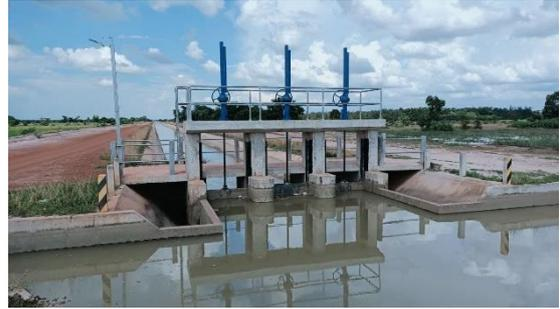
写真-10 円借款事業CP-P11で建設されたルムハック幹線水路の水位調節工
