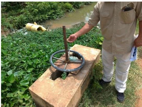
写真-15 コンボンスプー州ローレンチェリー地区WFP支援の取水口。ゲートを操作するハンドルがゆがんでいる
