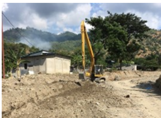
乾季（平時）のIGEによる河道内土砂の掘削作業（2022年5月）
