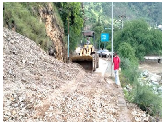
2021年4月洪水時の地すべり現場における、IGE所有のホイールローダーを用いた道路啓開作業
