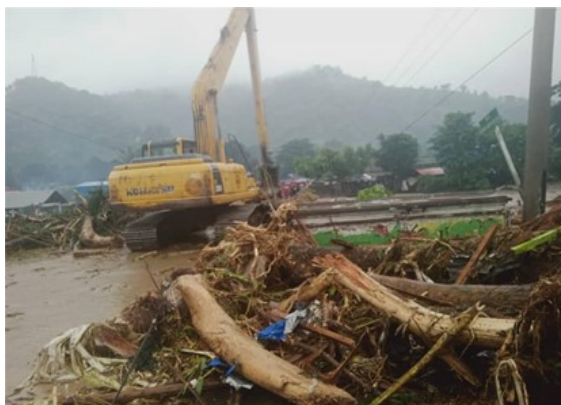
2021年4月洪水時の、IGEが所有する油圧ショベルを用いた河道内流木等の除去作業
