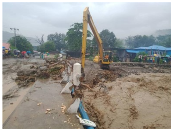
2021年4月洪水時の、IGEが所有する油圧ショベル（ロングアーム）を用いた河道内流木等の除去作業
