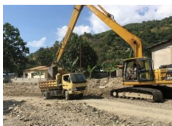
IGE所有の小型ダンプトラックによる河道内の堆積土砂の搬出（2022年5月）
