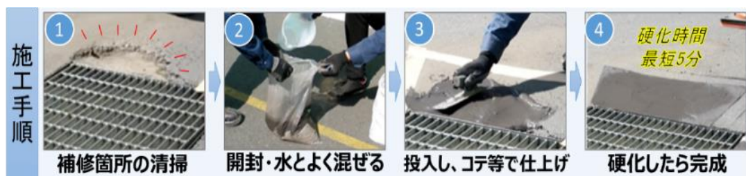
図6 ロックモル施工手順
