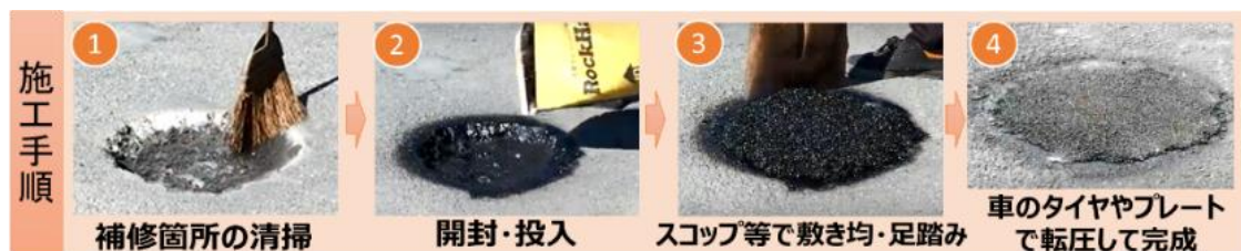
図 7 ロックハード施工手順
