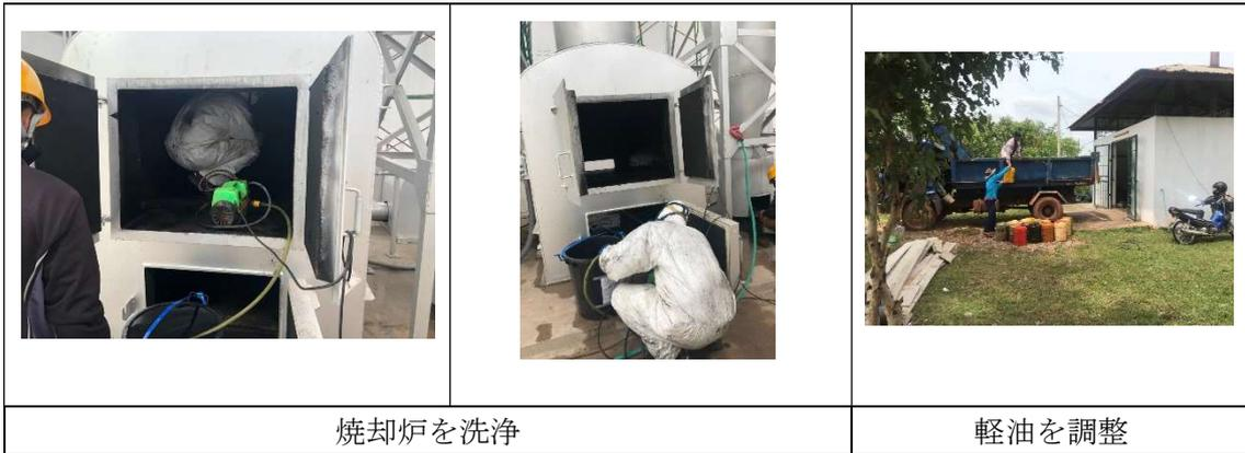
第6回現地業務時に焼却炉運営技術者からミスファイヤーランプが点灯しているとの報告を受けて焼却炉を確認した。原因としては、バーナの汚れを清掃する際、装置をリセットする必要があるが、今回はその対応をしていなかったため発生した点を確認された。技術者に対して、上記について解説して、トラブルが回避されるように指導した。
