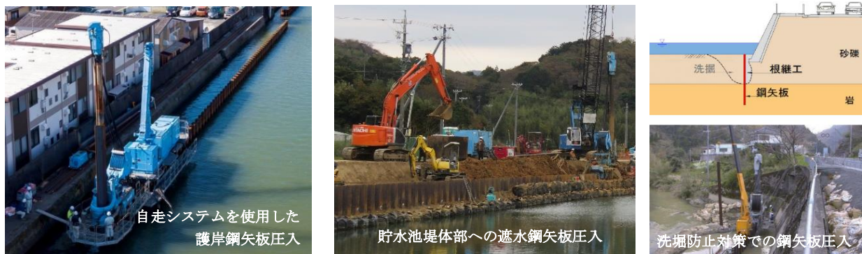
図5 サイレントパイラーを用いた施工例
