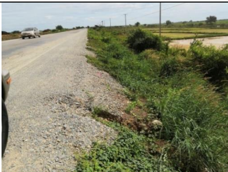
国道8号 20キロポスト (4車線拡幅工事中)
