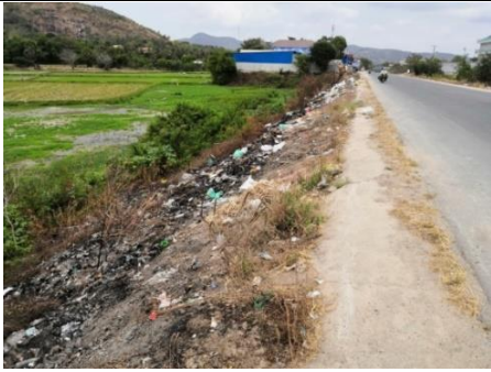
国道2号 124キロポスト (石張法面で整備済み)
