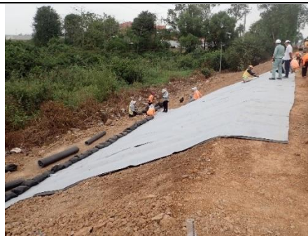
2022年1月適合性施工現場 (シート敷設状況)
