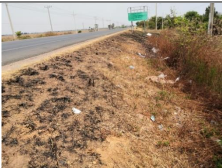
国道6号 340キロポスト (盛土法面、問題なし)
