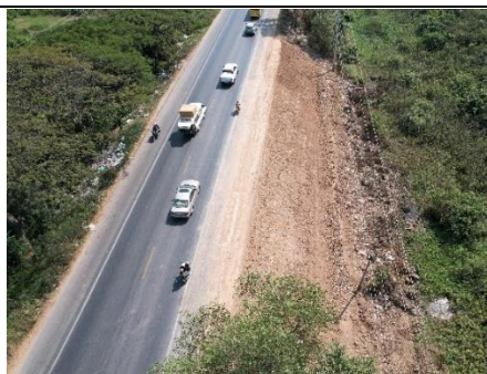
適合性施工現場状況 (施工直後)
