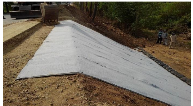
2019年試験施工（国道1号）
