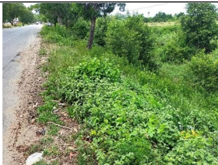
2019年試験施工現場 (3年経過)
