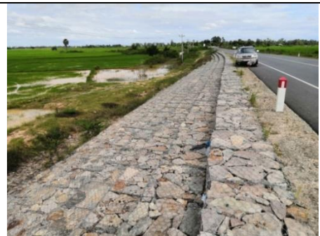
国道11号 18キロポスト (日本無償橋梁アプローチ部分)
