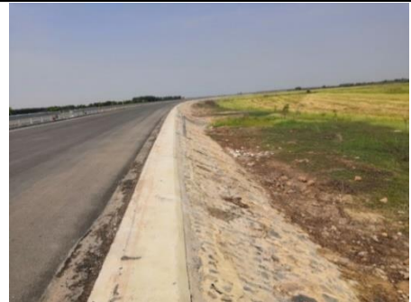
国道5号 シソポンバイパス (石張法面で整備済み)
