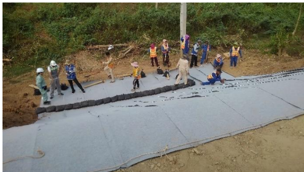
2019年試験施工（国道1号）
