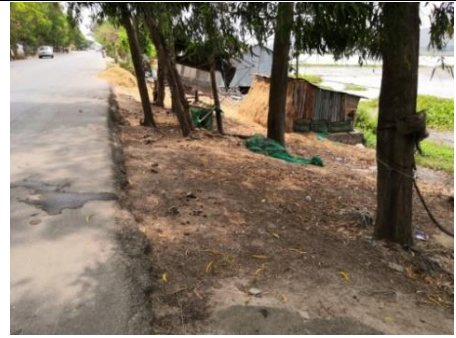
国道2号 115キロポスト (民家近くの法面、雨が流れた後有)
