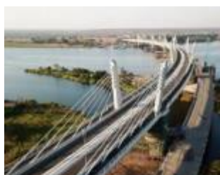
カズングラ橋
