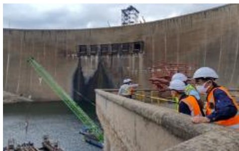
補修中のカリバダム、資金不足と想定外の地質状況で遅れが見込まれる。
