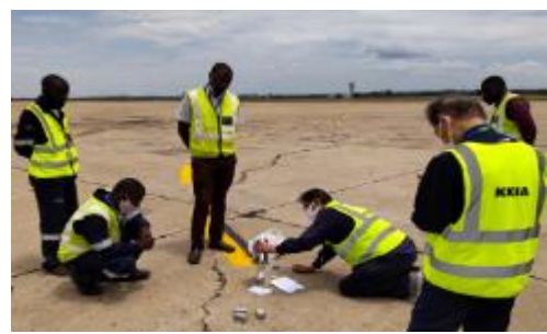
ルサカ国際空港のエプロンを ALPHATEC380 で補修実演。
