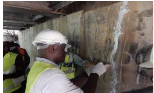
Lusemfw Bridge OJT で RDA 技術者がひび割れ注入補修を実習。
