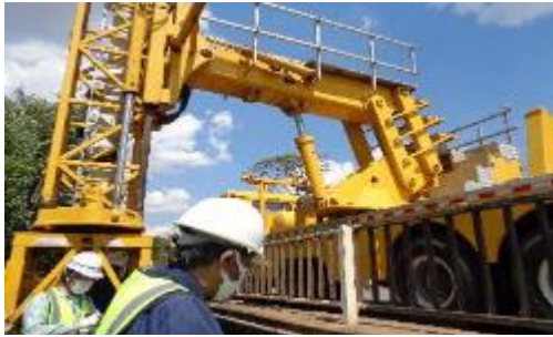
Lusemfw Bridge の OJT で橋梁点検車による損傷状態確認。
