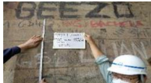
Luangwa South Bound Bridge のモニタリングで現地適合性が確認された。
