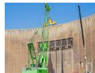
カリバダム改修
