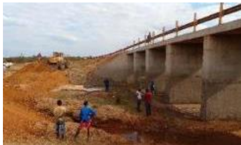
ザンビアの施工業者が提案製品でコンクリート補修を行った Luena Bridge。
