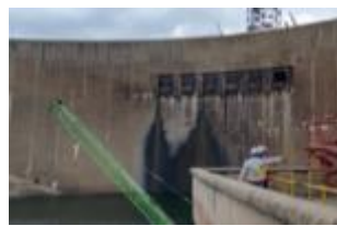
カリバダム改修
