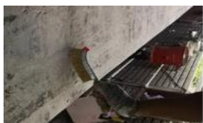
ひび割れ面清掃
