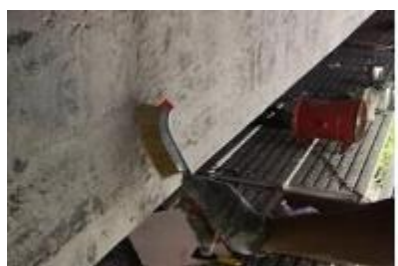
①ひび割れ面清掃
