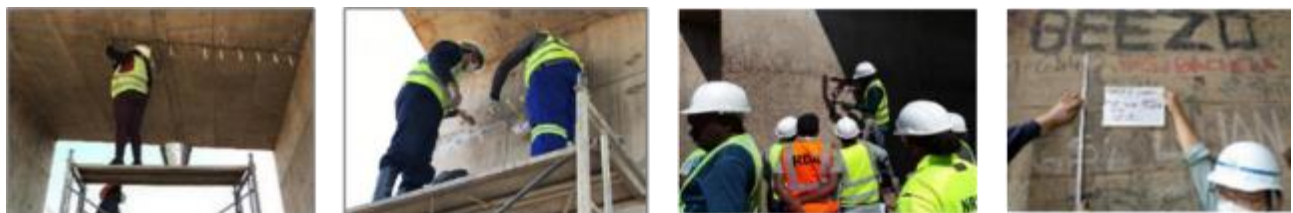
現地施工業者によるひび割れ注入補修
