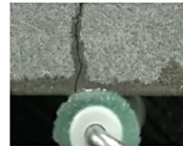
塗布するだけで天井面ひび割れに浸透
