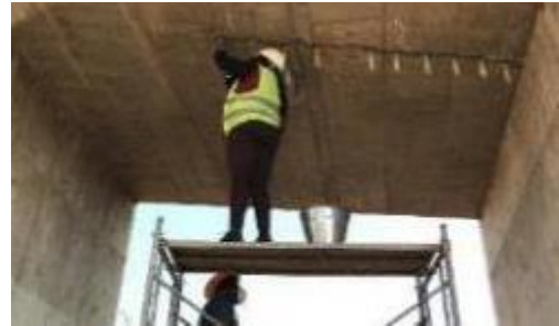
Luena Bridge の床版下面ひび割れ補修で施工業者が低圧注入器を設置。
