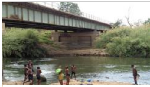
2019 年の OJT で補修した Luangwa South Bound Bridge。
