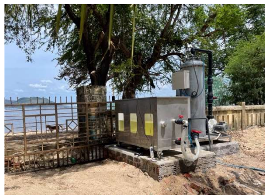
機材の稼働開始 (2022年6月1日)
