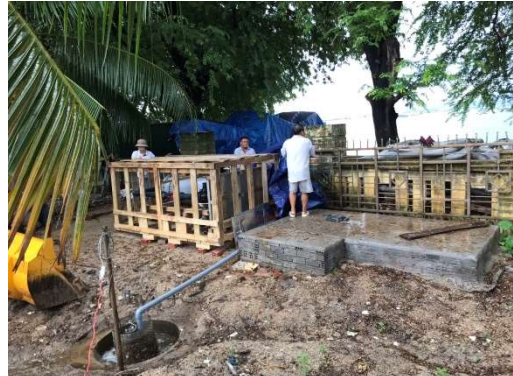
機材撤収作業 (2022年10月3日)
