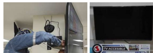
テレビ設置器具設置作業(6) 2022年1月
