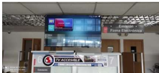
テレビ設置器具設置作業(3) 2022年1月
