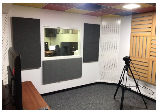
スタジオ工事 (2022年2月)
