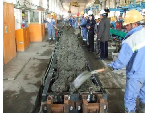
枕木型枠のコンクリート量の調整作業
