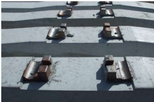
M-01 締結装置用枕木上部の外観 (ショルダー)
