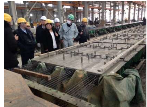
極東興和 コンクリート注入済の枕木型枠
