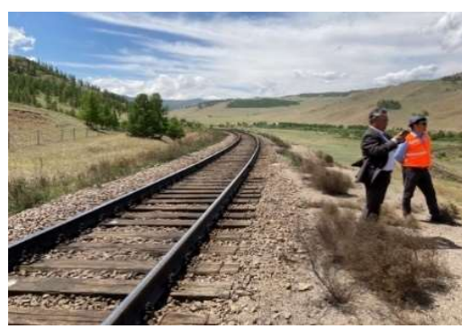
木製枕木急カーブ区間の視察(35 エリア)
