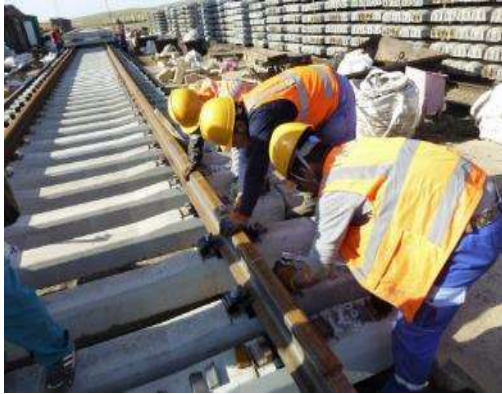
M-01 締結装置の組立作業
