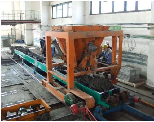
枕木型枠にコンクリートを注入
