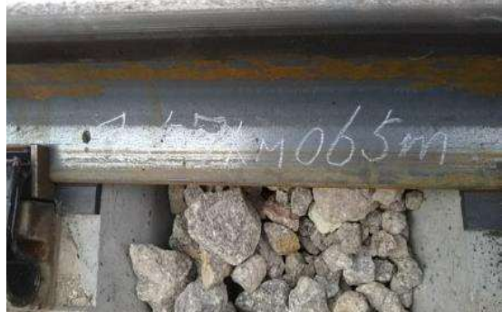
手順 b-3 : 測定箇所の決定(ロシア国境より 457km65m の地点)
