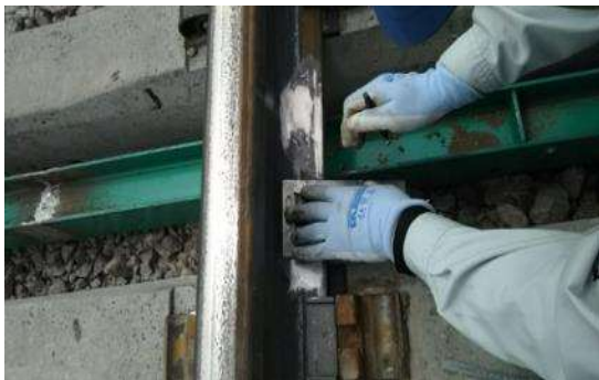
手順 d : 測定箇所のレール研削
