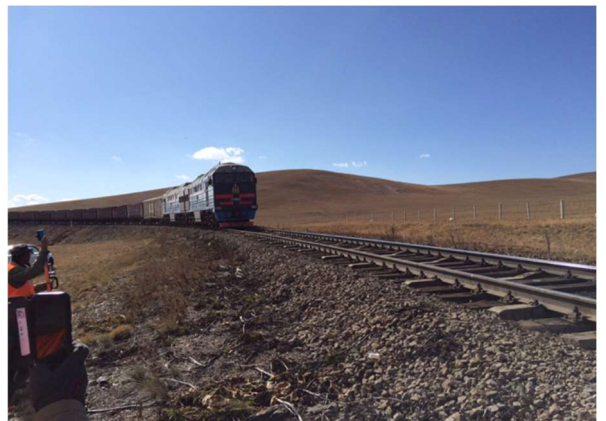
ハイルハン敷設工事付近での列車運行 (2017年10月12日)
