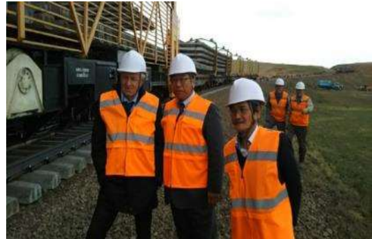
敷設工事現場にて
