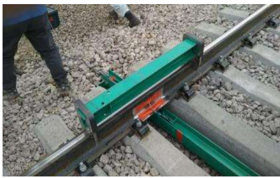
手順 h-1 : 輪重測定用治具の取付け確認
