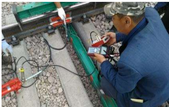
手順 i-1 : 輪重測定用ひずみゲージ動作確認
