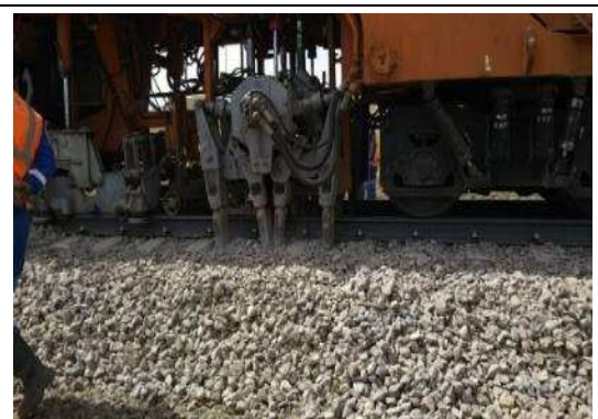
バラストの突き固め作業
