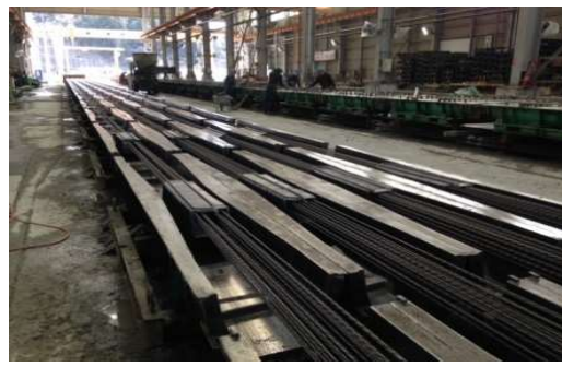
極東興和 鋼線を張った枕木型枠
