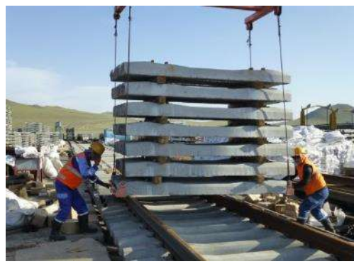
枕木をレール上に並べる作業
