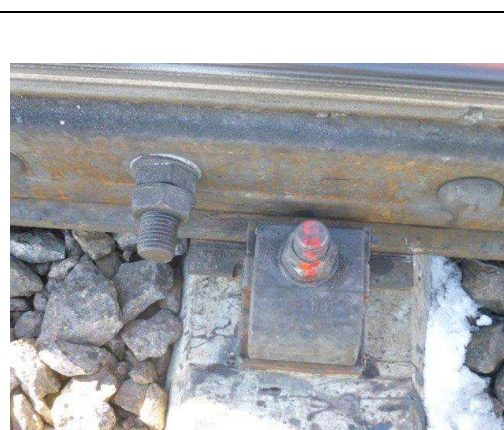
ナットは緩んでいないことを確認
