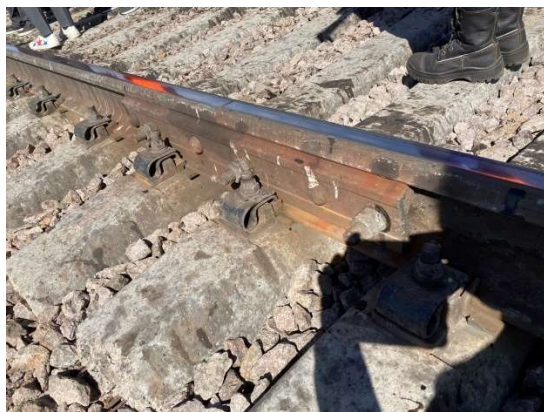
軌間外側の締結状態
