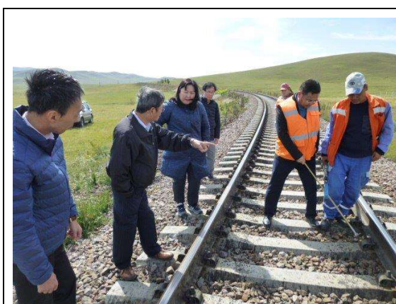
ハイルハン M-01 締結装置敷設現場点検
