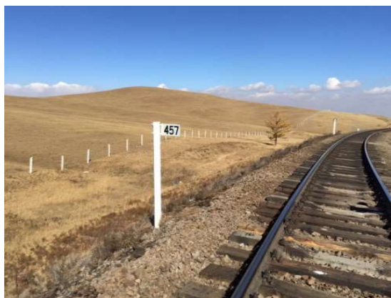
工事敷設予定現場
