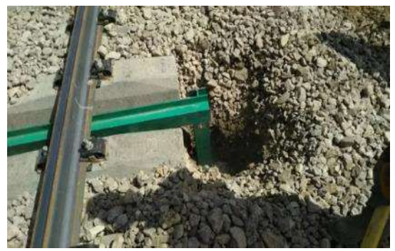
手順 c-2 : 測定のための治具(H鋼)の張付
