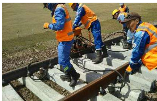
敷設工事バラスト突き固め風景
