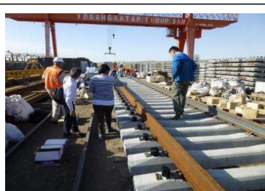
M-01 締結装置の組立作業現場
