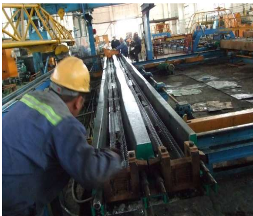
左右の両枕木型に PC 鋼線を張ったところ
