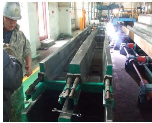
M-01 締結装置用枕木の PC 鋼線緊張装置取付け部分
