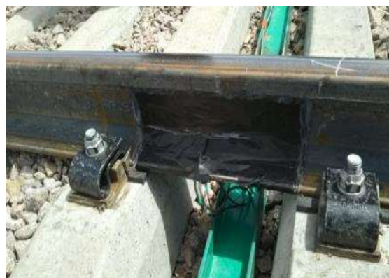
手順 1-2：板ばね・締結ボルトの現状復帰
