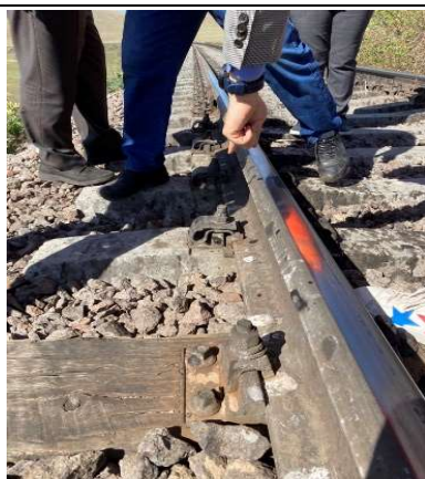
隣接する軌道の木製枕木区間
