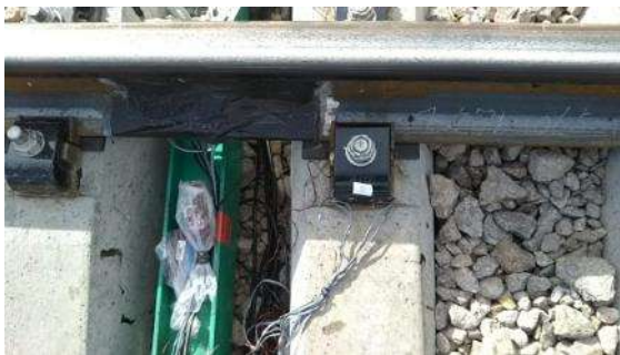
手順 k-2 : 板ばね応力と締結ボルト軸力測定の前準備
