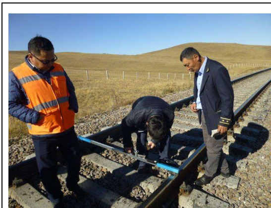
軌間測定器にて軌間測定中
