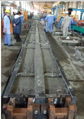
第1号 M-01 締結装置用枕木型枠への最終作業完了
