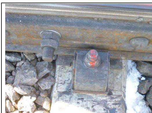
ナットが緩んでいないことを確認
