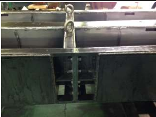
佐藤工業所 枕木型枠のつなぎ目(分割輸送する)
