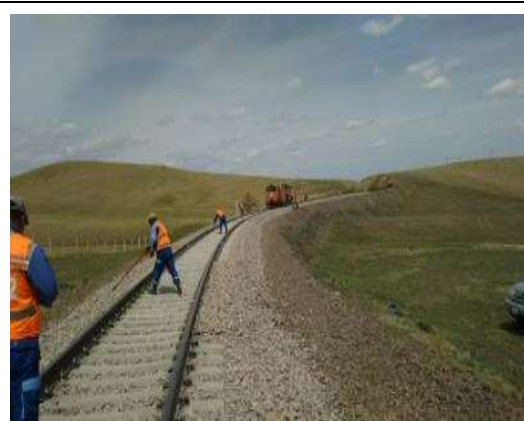
敷設後の軌道調整作業
