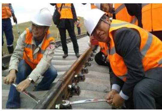
敷設工事現場にて締結式
