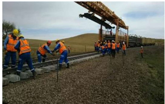
ハイルハン敷設工事(2018年5月11日)
