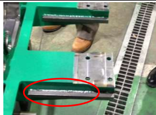
佐藤工業所 溶接部分を修正することで調整した
