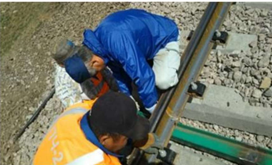
輪重、横圧、レール変位、板ばね応力、締結ボルト軸力測定準備(2018年5月14日)
