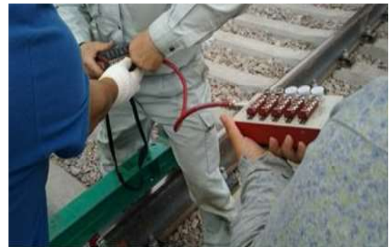
手順 h-2 : 輪重測定用ひずみゲージ動作確認
