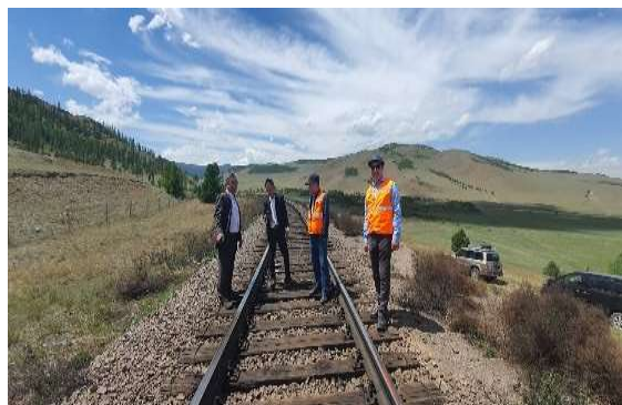
木製枕木直線区間の視察
