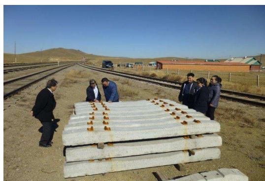
敷設現場管理事務所脇の M-01 締結装置用 予備枕木 28 本
