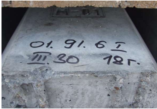
ロット番号「第1回91番の枕木型枠の6個目 2018年3月30日製造」が記載された枕木
