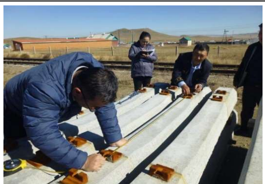
枕木のショルダーの間隔を測定
