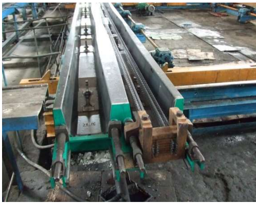
右列の枕木型に PC 鋼線を張ったところ
