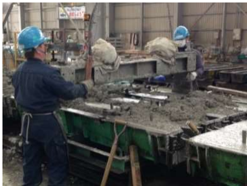
極東興和 枕木型枠にコンクリート注入
