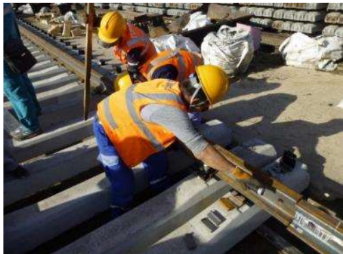
枕木の間隔調整作業
