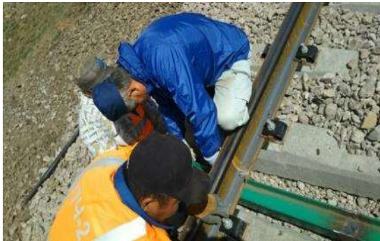
手順 c-1 : 測定のための治具(H鋼)の張付
