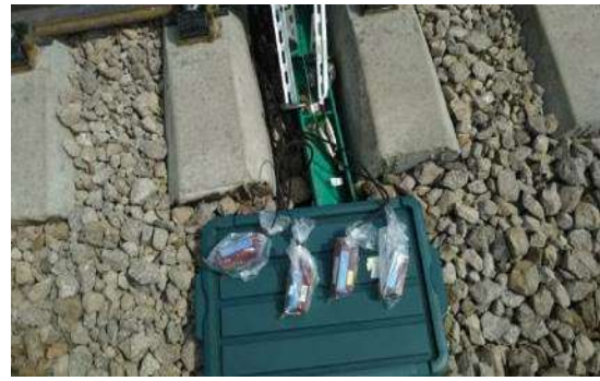
手順 g-2 : ケーブル接合部の防水対策
