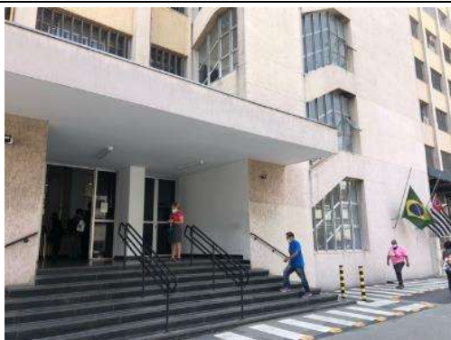
サンパウロ州保健局の建物
