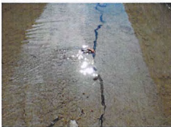
図 3.4-9 矩形水路断面のクラック
