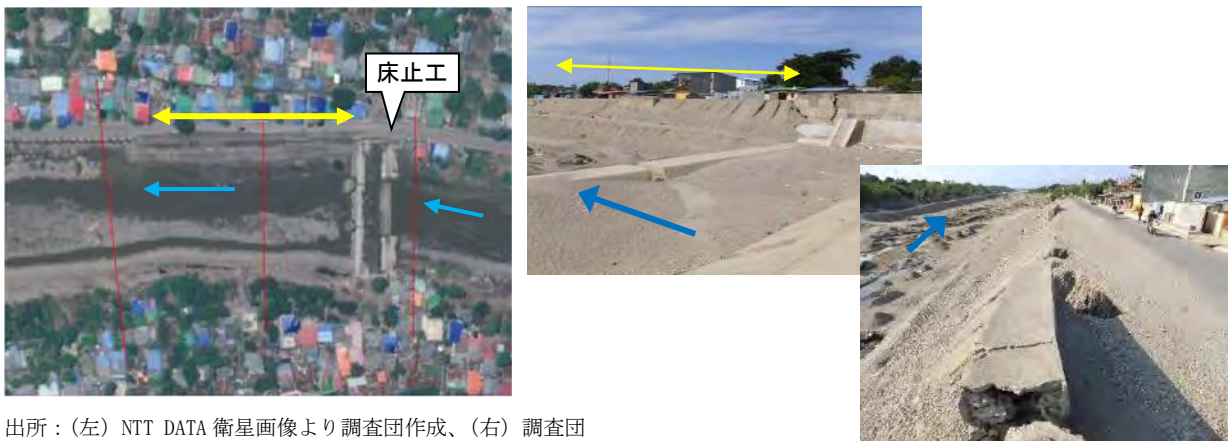
図 3.2-21 護岸の被災 (R4)
