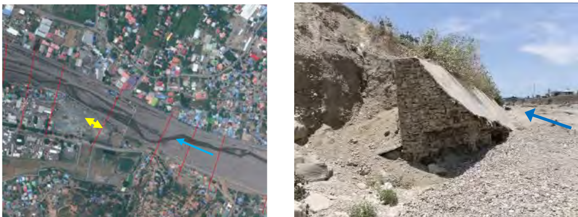
図 3.2-18 護岸の被災 (L2)
