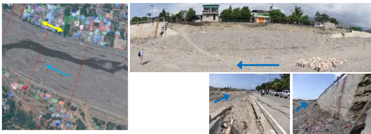
図 3.2-23 護岸の被災 (R6)
