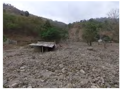
右岸 6.1km 付近の川裏側：背後の山からの土石流により家が埋没
