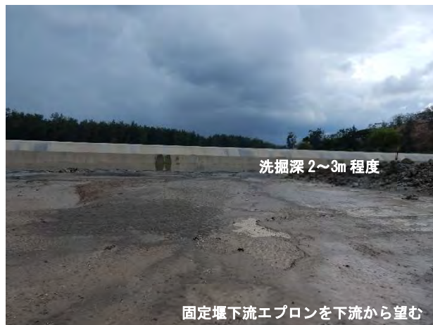
図 3.4-7 プルト頭首工下流エプロン部洗掘状況
