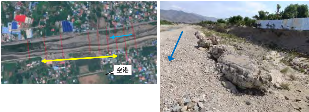
図 3.2-17 護岸の被災 (L1)
