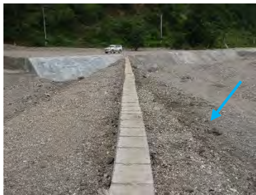
2013 年 6 月：水制先端から護岸方向を望む
