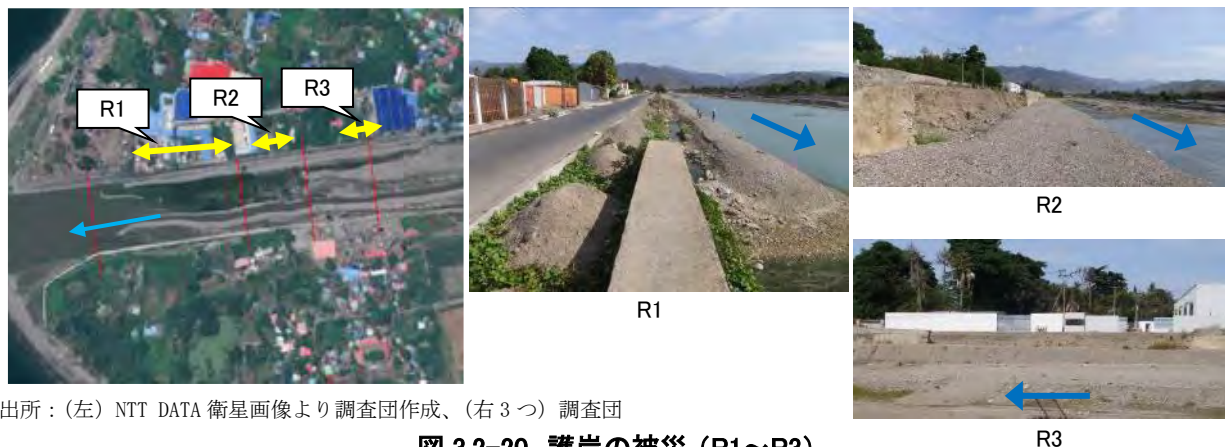
図 3.2-20 護岸の被災 (R1～R3)
