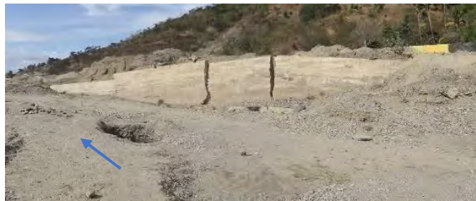
2021 年 10 月：上流より水制工全体を望む
