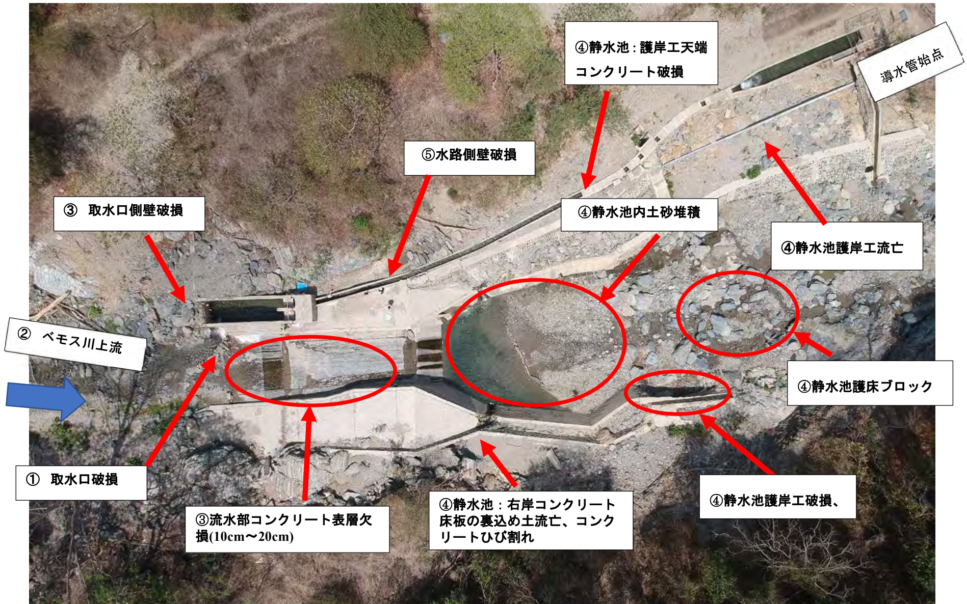
図 3.3-5 ベモス取水堰被害箇所
