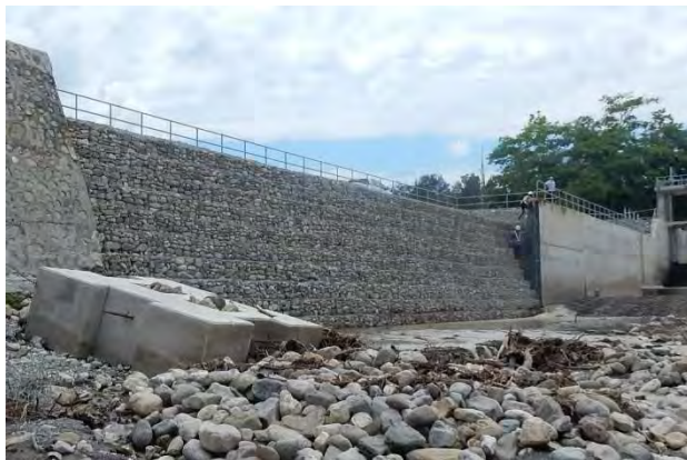
図 3.4-5 倒壊部の仮設ふとん籠写真
