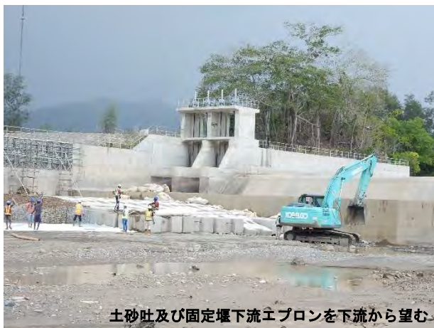
図 3.4-7 プルト頭首工下流エプロン部洗掘状況
