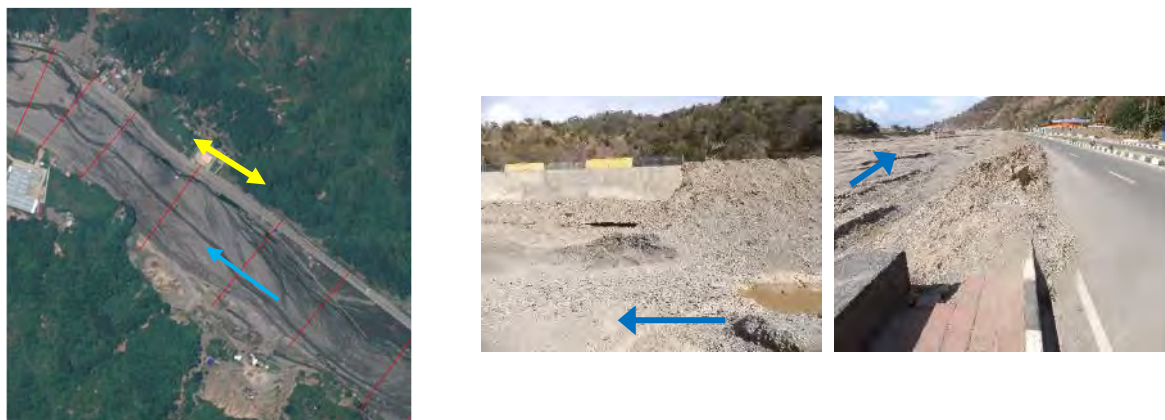
図 3.2-27 護岸の被災 (R10)
