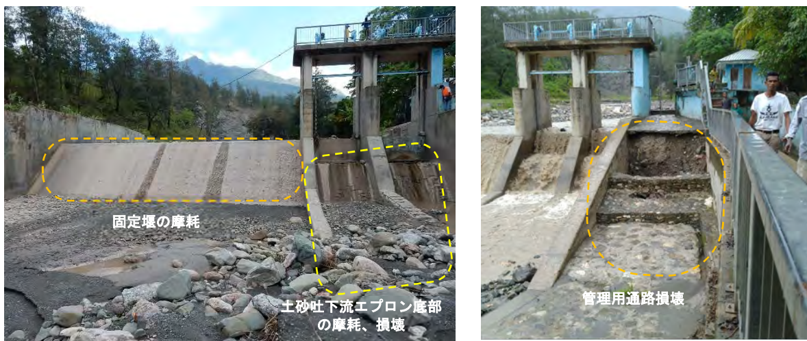
図 3.4-10 マリアナ頭首工固定堰、土砂吐下流部エプロン、管理用通路の摩耗、損壊状況
