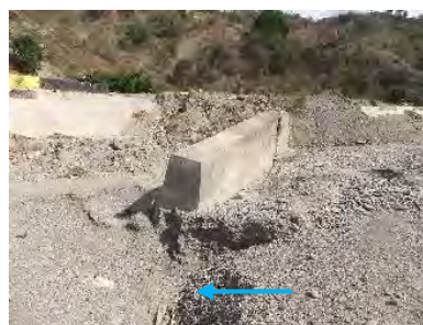
2021年10月：水制工先端から護岸方向を望む
