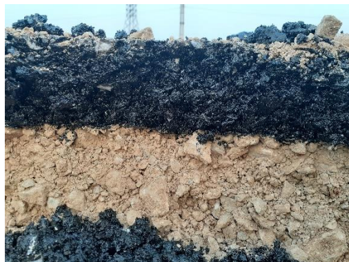
現地道路における新設舗装断面
