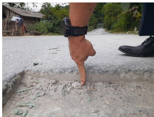
現地道路補修 (カッター断面)
