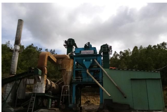
現地アスファルトプラント施設 (1)
