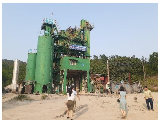
現地アスファルトプラント施設 (2)
