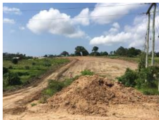
南部バイパス道路の整備の様子
