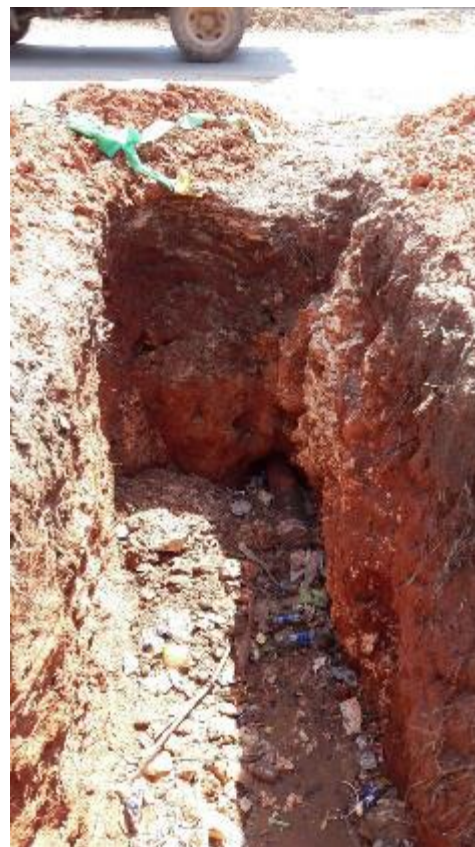
リコニ・ウクンダ道路沿いの管布設工の様子
