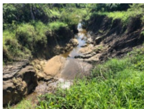
(b) 自然水路中流部（護岸工地点）
