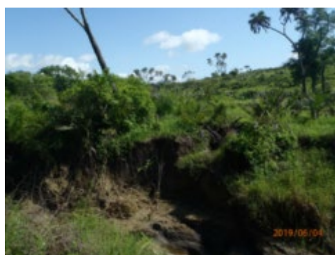
(c) 自然水路中流部（護岸工地点）
