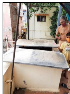
屋上の貯水用タンク
