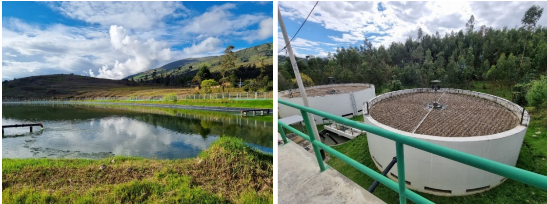
本事業により建設され稼働中の下水処理場 左:セレンディン市(ラグナ方式) 右:カハバンバ市(散水路床方式)
