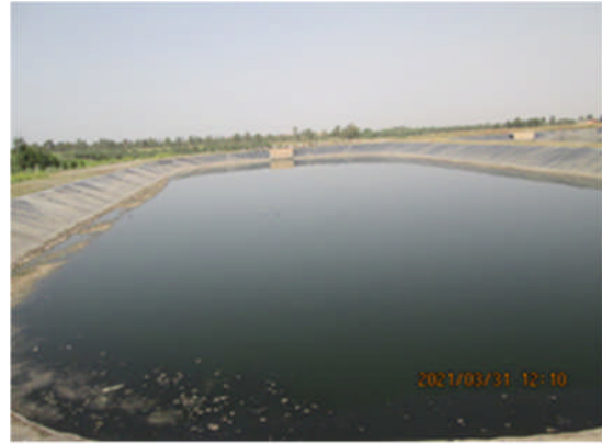
本事業で整備された下水処理施設 (アミズミズ市)
