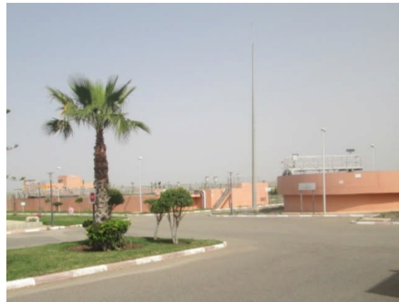
写真 2 : OCP 資金により整備された下水処理施設全景 (ベン・ゲリール市)
