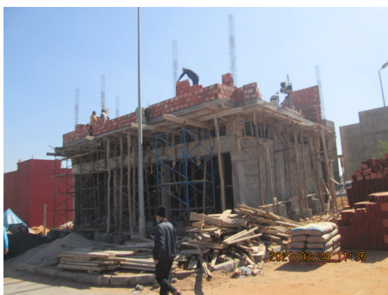
写真 3：建設中の住宅
