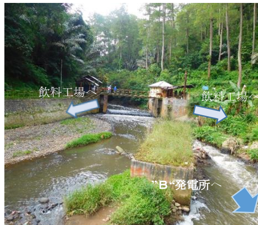
図 2-2 “B” 発電所の取水口
