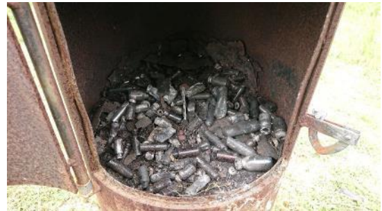
破損した医療廃棄物用焼却炉。注射針などの焼却残 渣が残っている (レイ)
