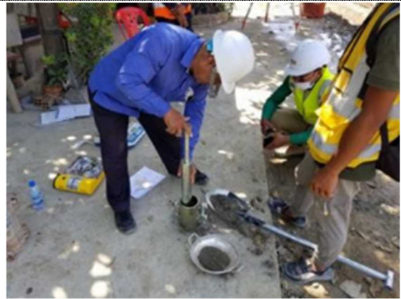
STEIN 施工研修 (土質試験の OJT)
