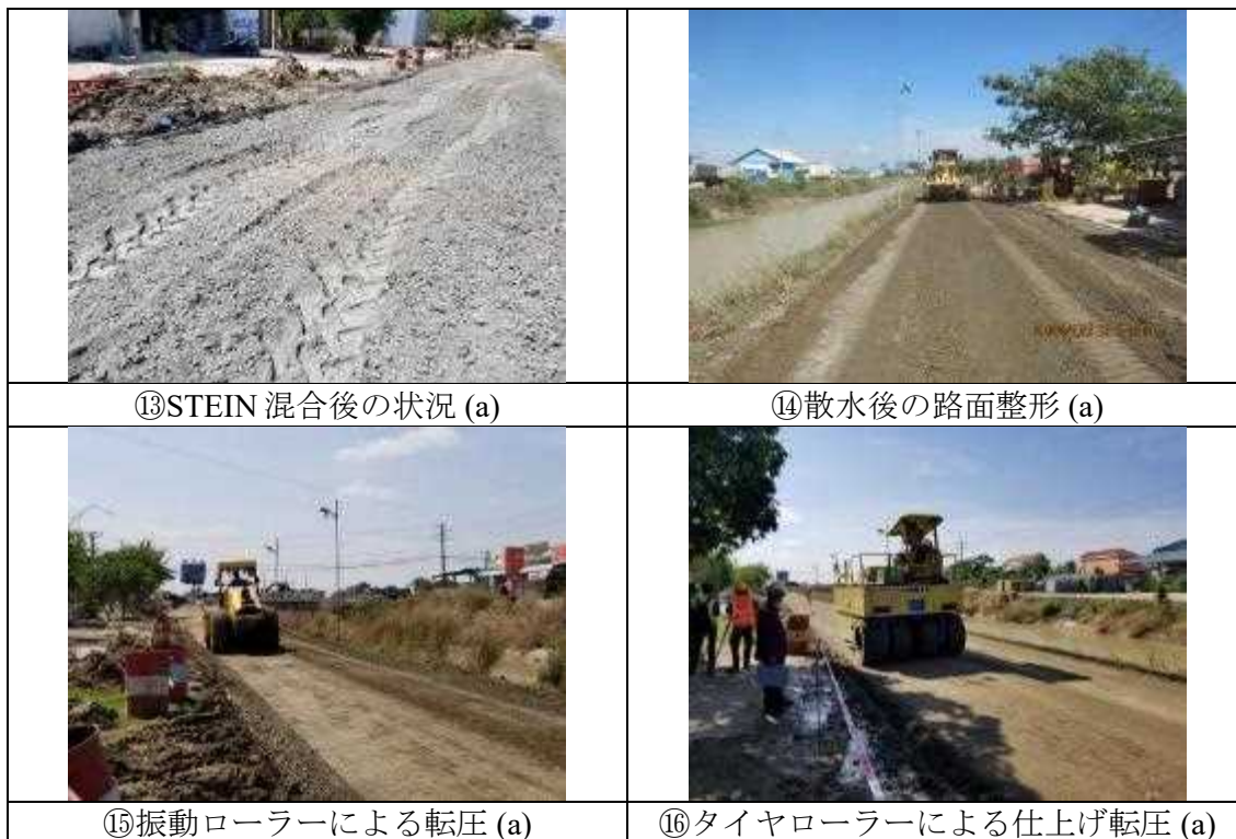
図 3.10 STEIN 混合後の散水、水分の攪拌、不陸整正、転圧
