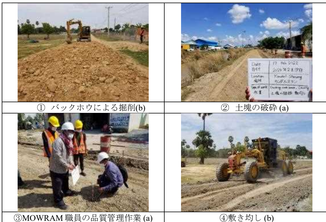
図 3.7 掘削・土塊の破砕
