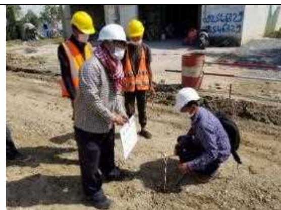
MOWRAM 職員による QC 作業（掘削深確認）
