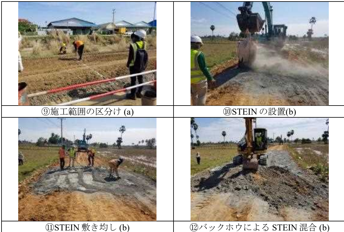
図 3.9 STEIN 散布と混合
