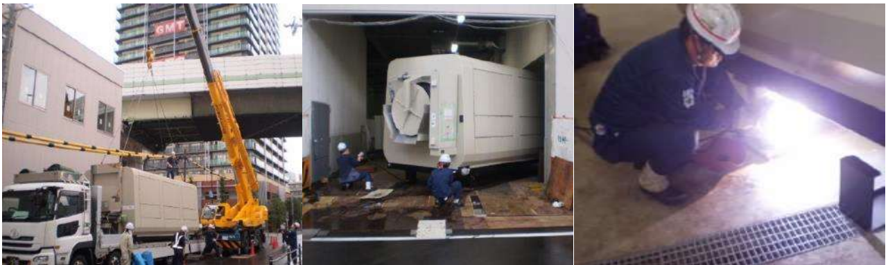
図 37：日本での取付作業の様子
