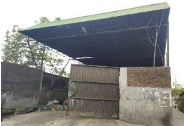
STS 外観（北ダッカの事例）
