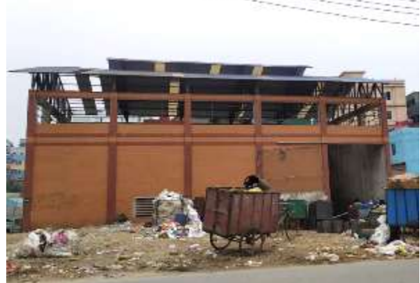
STS 外観（南ダッカの事例）
