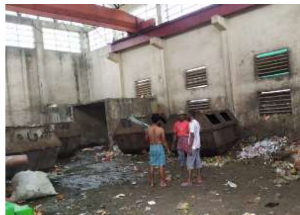
STS 内観：ADB 支援で天井クレーン有り、コンテナ有り（南ダッカ Hazaribag の事例）
