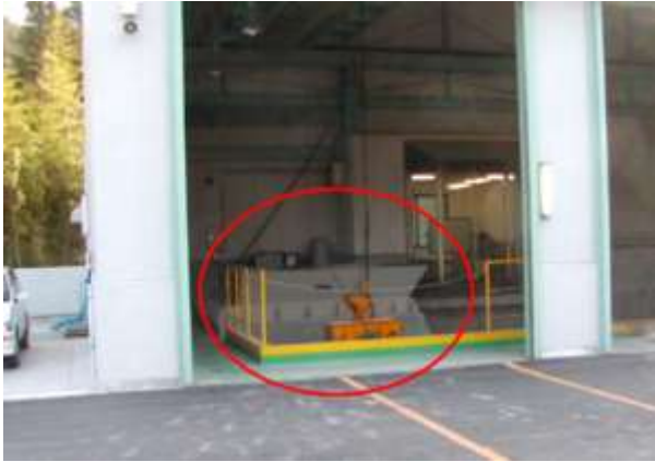
地下に提案製品を導入した事例（地上部分）
