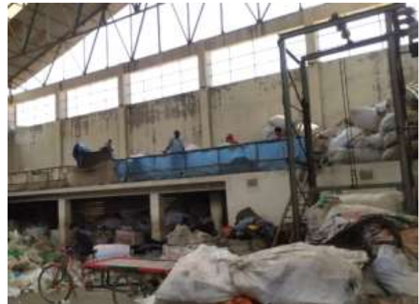
STS 内観：ロフトのような構造有り、機械設備有り（ADB 支援の南ダッカ Jurain の事例）
