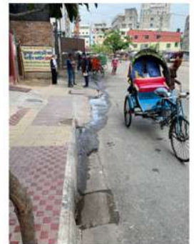
STSからマンションに向かって流れる排水
