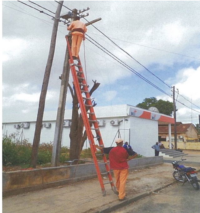
図 6.2-18 EDM 配電作業者の昇柱作業の様子
