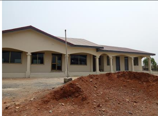
建設中の Ga West District Assembly 議会場（グレーター・アクラ州）。左記同様。
