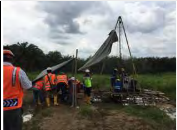
ボーリング調査
