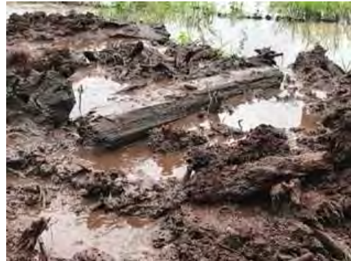
試掘状況 STA8+610 付近 未分解の幹
