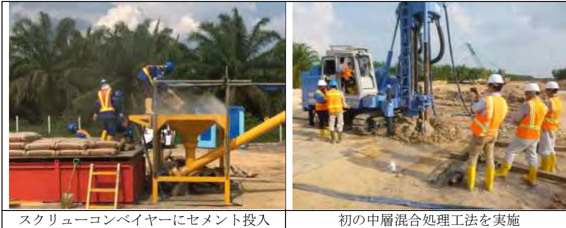
写真 7 地盤改良工の実施
