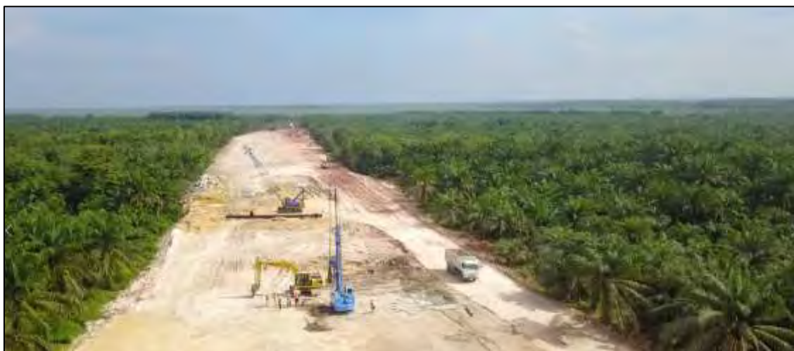
写真 4 試験施工実施対象地の鳥瞰写真
