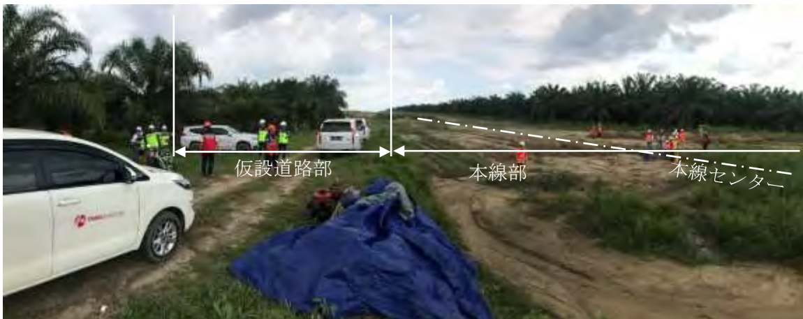
写真 5 STA8+600 付近の全景
