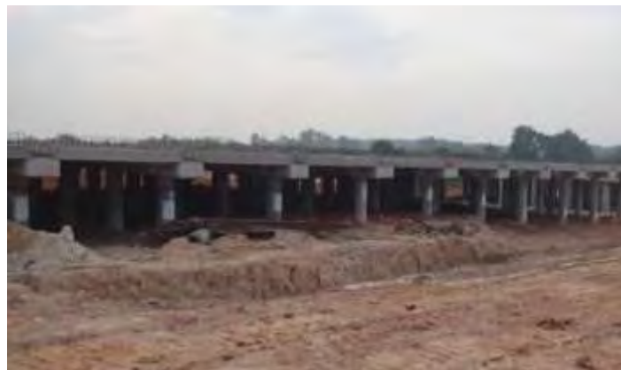
写真 パイルスラブ工法の施工状況（ドゥマイ地区）
