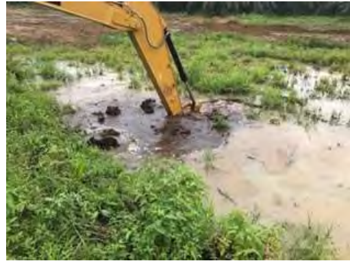
バックホウでの試掘状況 STA8+610 付近
