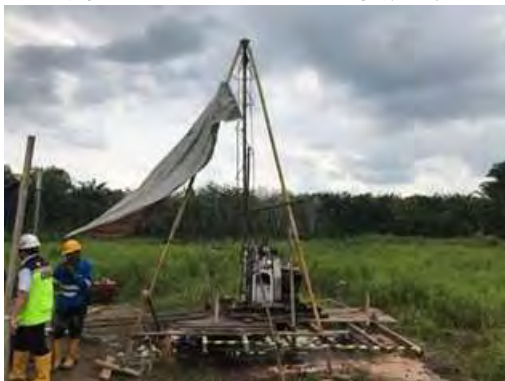
ボーリング調査状況 STA8+600
