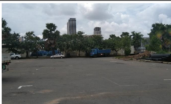
写真-5：ろ過池建設予定地 ろ過池の建設予定地はある程度利用面積が確保されている。（写真の右半分エリア）
