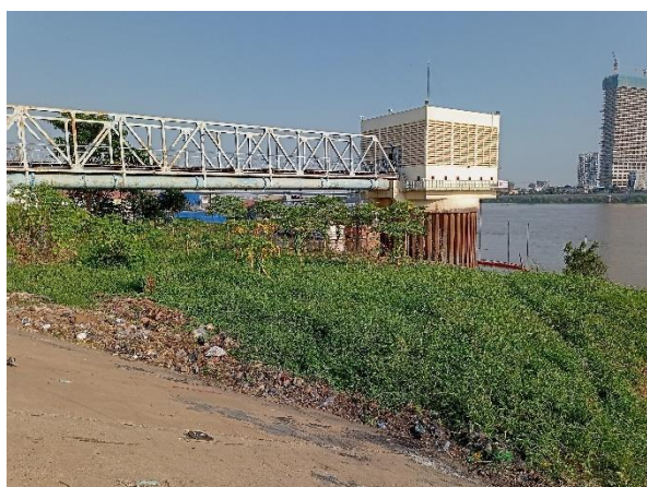
写真-1：取水施設予定地の現状 取水施設建設予定地には、既存の取水塔がある。増設されるフロート式取水施設は既存取水施設の敷地内に建設される計画である。
