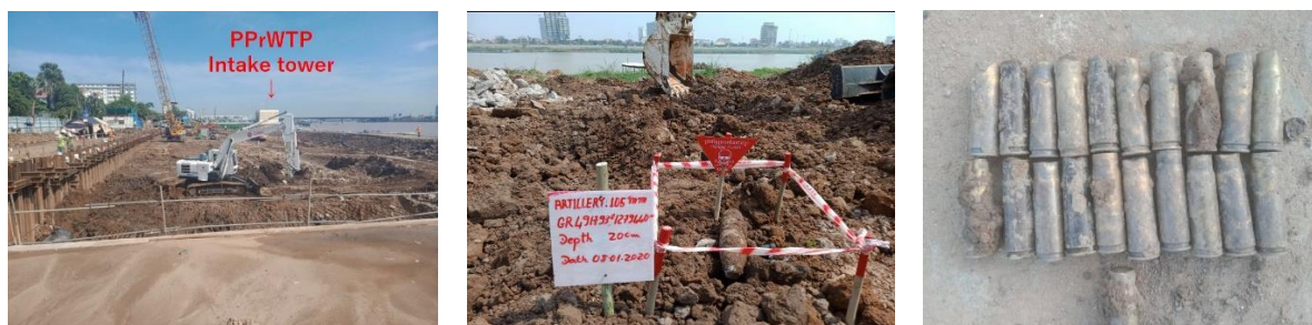
図 3-4.4 取水場隣接地における UXO 撤去作業（撮影：CMAC）
