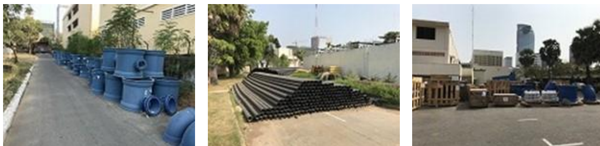
図 3-4.2 浄水場内の仮置き資材
