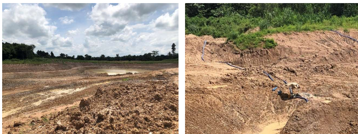
写真 41 (左) 整備中のため池、(右) ため池整備に使用している排水用ポンプ
