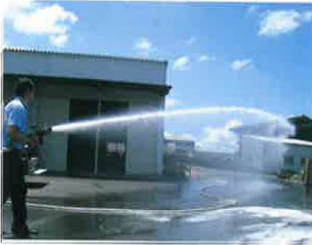
写真 19 SYSCUE による放水の様子
