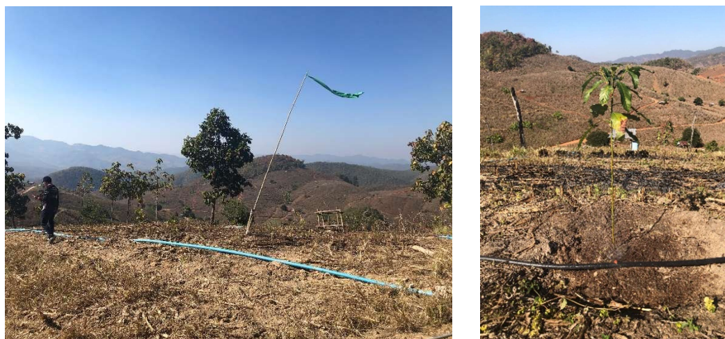
写真 28 (左) パイプライン、(右) チューブ灌水 出典：調査団撮影
