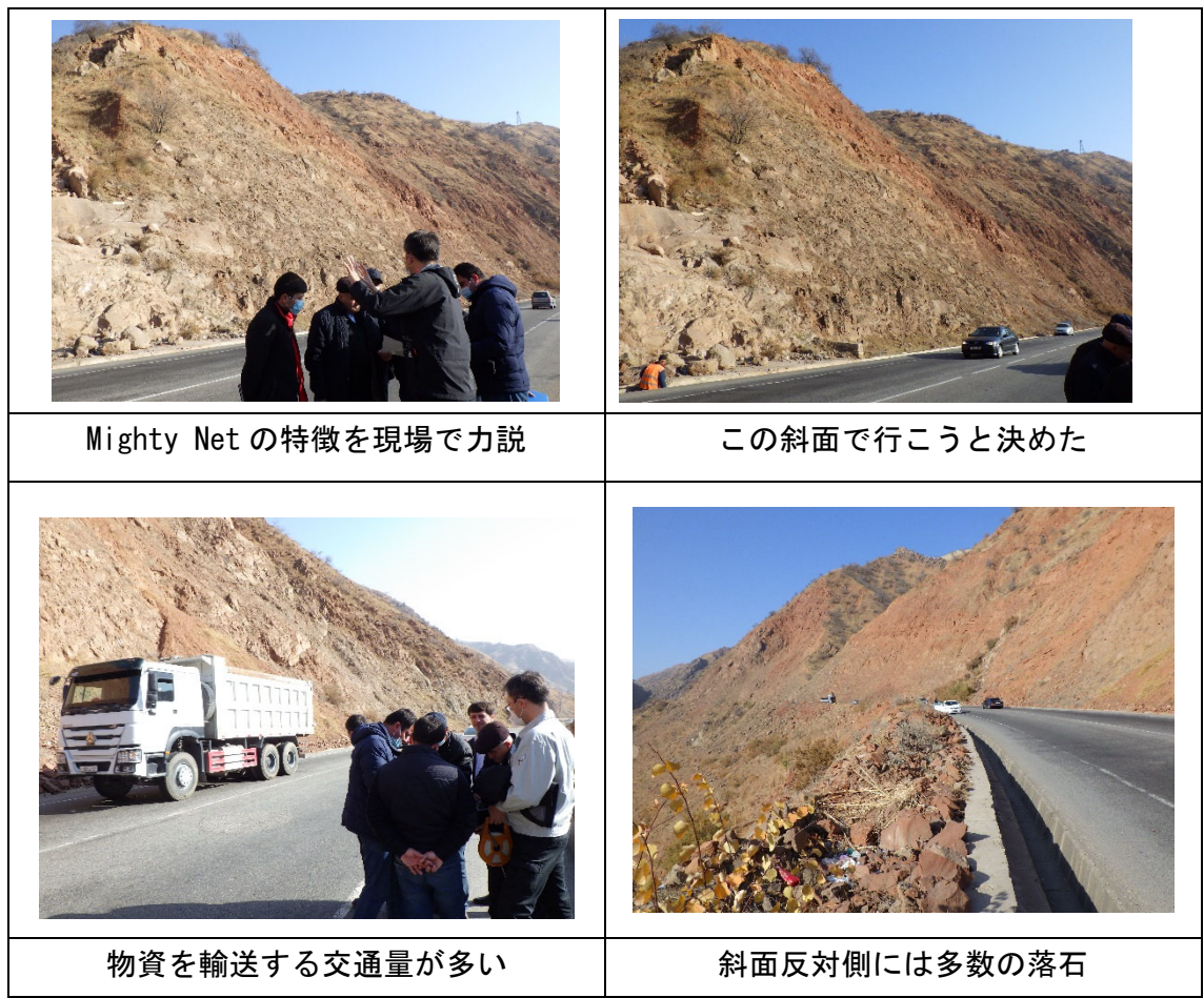
写真 斜面の状況
