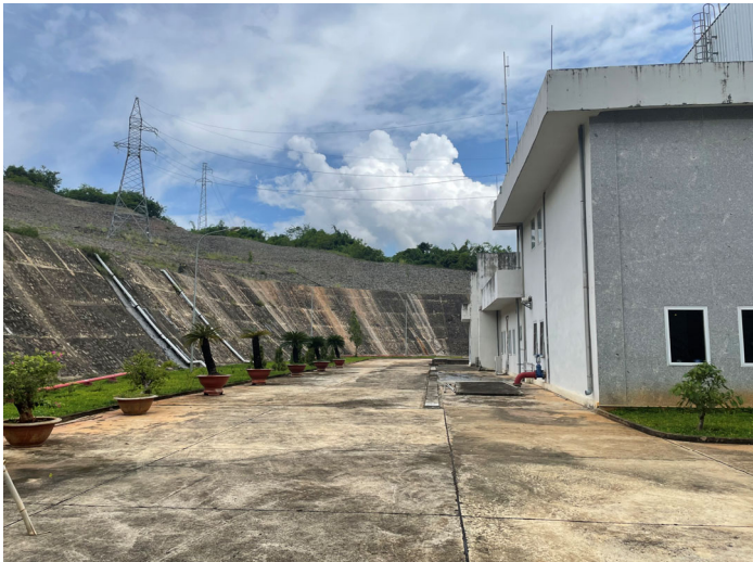
タクモ水力発電所外観
