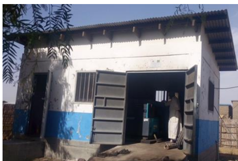
Generator House (Mito)
