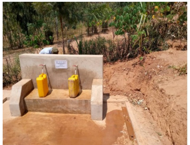
本事業施設から配水管を延長して郡が設置した公共水栓 （ガツィゴ郡レメラセクター）
