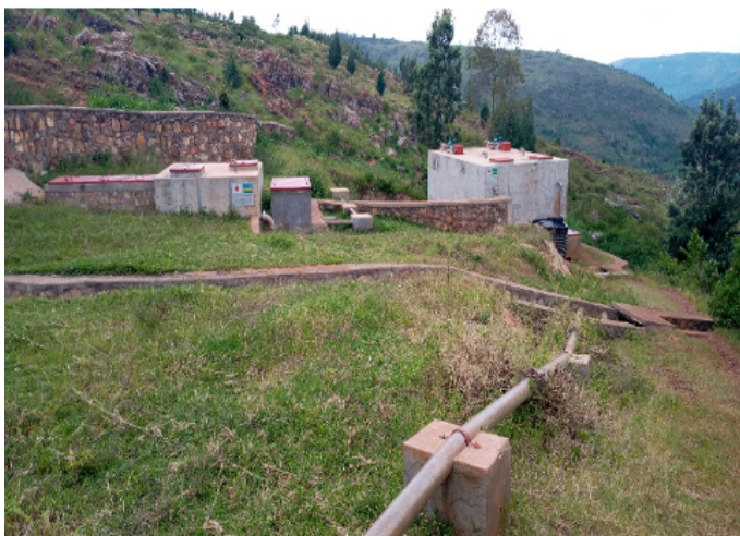
湧水取水施設（左）、集水槽（右）、送水管（手前） （ンゴマ郡ルキラセクター（ルキラ東サイト））
