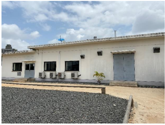
制御棟（イララ変電所）
