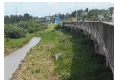
ケラ二川付近に建設された高架橋
