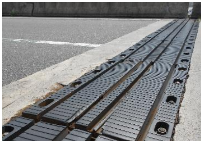
本事業区間のエキスパンション・ジョイント
