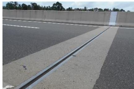
他の区間のエキスパンション・ジョイント
