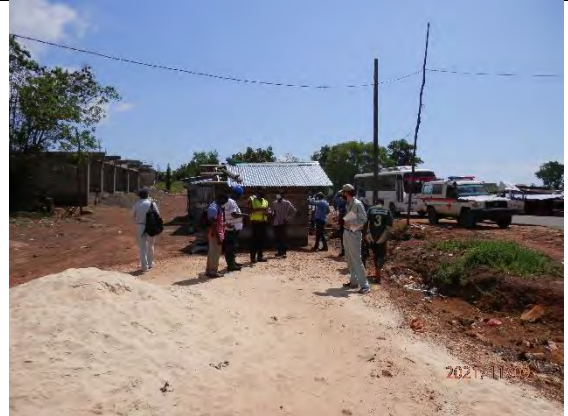
2 次変電所新設予定地④ John Obey 配電用変圧器は 200kVA × 2 台柱上型を計画。
