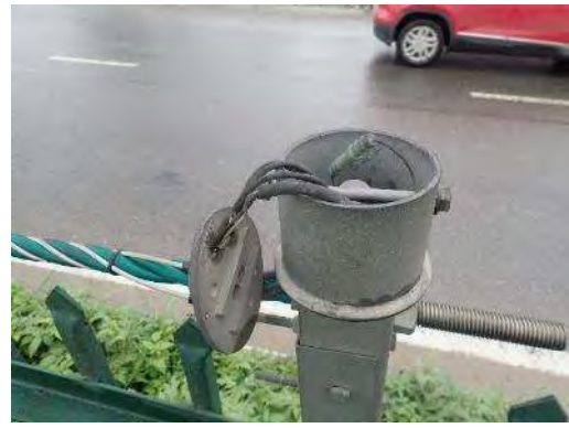
N-M 道路・K-B 道路 盗難破損状況
