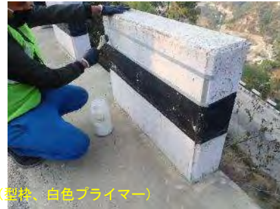
設置作業 (塗布)
