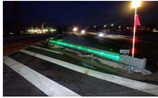
ナクダウンガトンネル アプローチ道路
