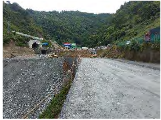
アプローチ道路（西側）視察
