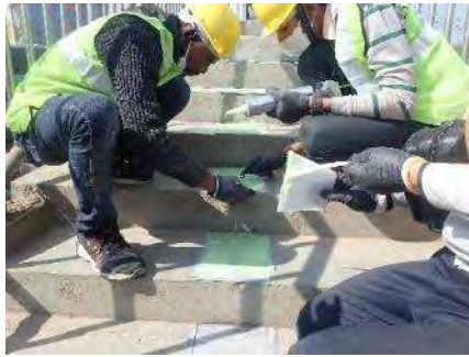
K-B 道路（ジャリブティ歩道橋：歩道橋の踏み面）：蓄光樹脂塗料施工
