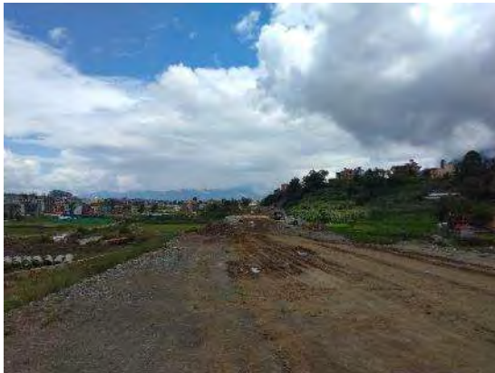
アプローチ道路（東側）視察
