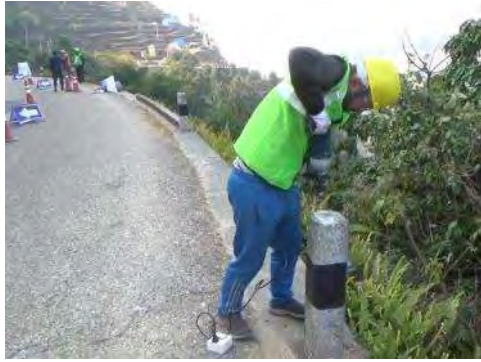
シンズリ道路 第2工区 (クルコットから約19.0km : コンクリート柱) : LED 発光線 (縦型)
