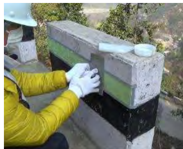
シンズリ道路 第2工区（クルコットから約5.2km：コンクリートブロック）：蓄光樹脂塗料
