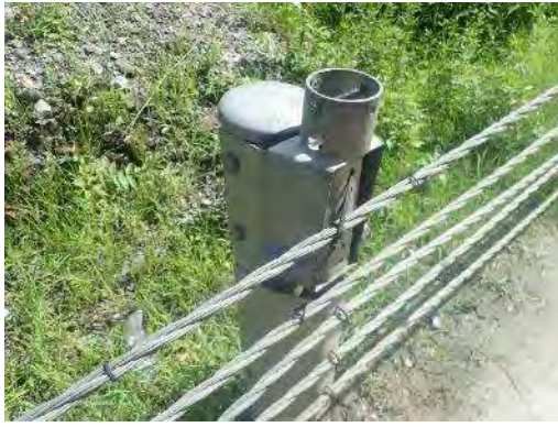
N-M 道路・K-B 道路 盗難破損状況
