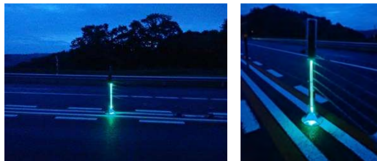
写真 8 中央分離帯の端末支柱に縦型を設置した例
