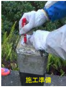
設置作業（ドリル削孔）
