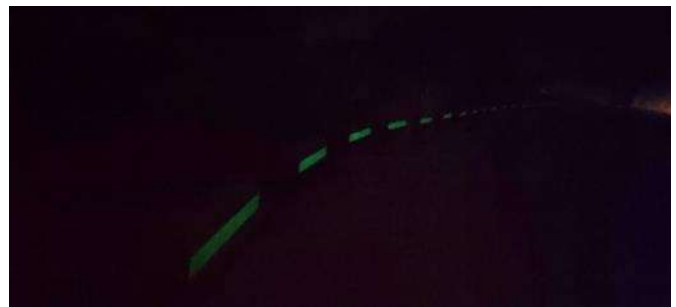
シンズリ道路 第2工区（クルコットから約5.2km：コンクリートブロック）：蓄光樹脂塗料
