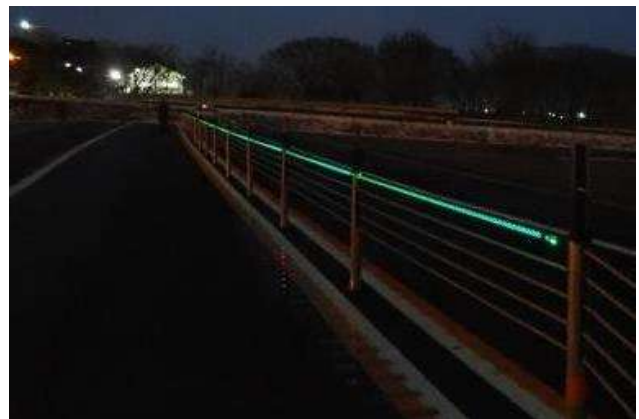
写真 6 LED 発光線設置状況
