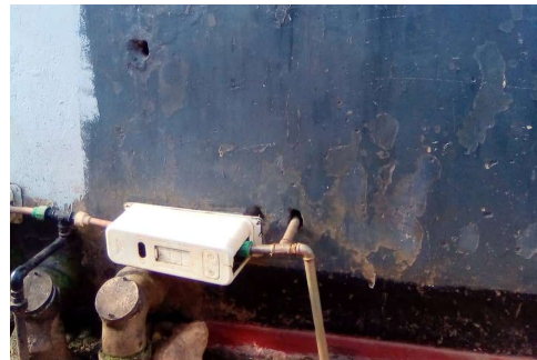
盗水から PPWM を保護：地上設置(左) と壁設置 (右) ルサカにて
