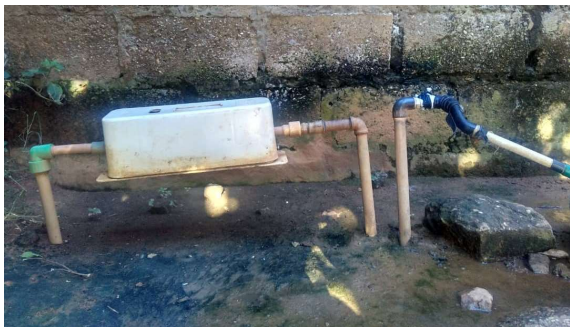
盗水から PPWM を保護：地上設置(左) と壁設置 (右) ルサカにて
