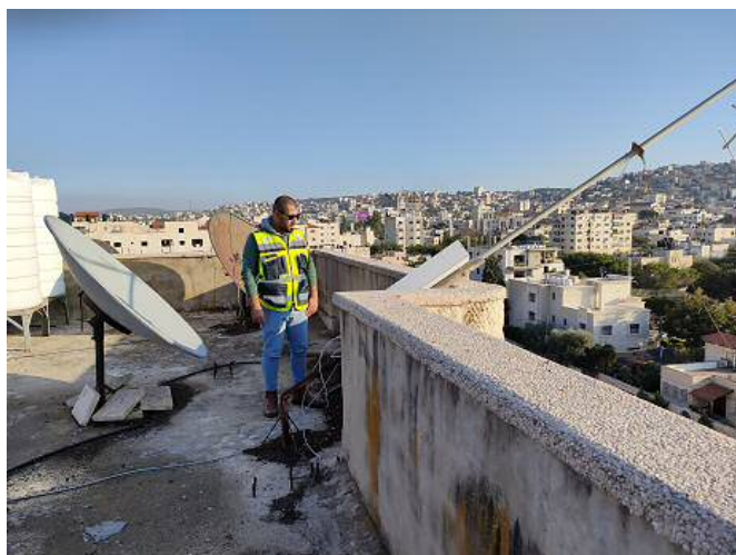
صورة 6.2 تركيب لاقط هوائي على سطح @مارة .
