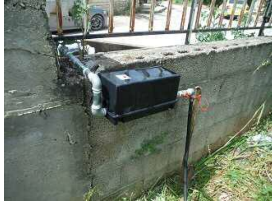
صورة 6.3 طريقة التركيب الأفقي.
