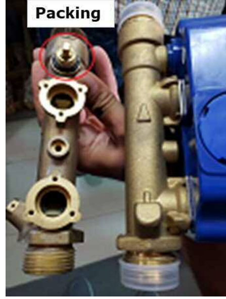
الصورة 10.2: الجزء الذي يسمح بتسريب المياه إلى داخل عداد الدفع الماء.
