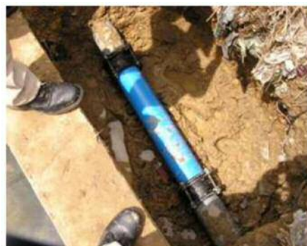
إصلاح التسريب عن طريق قن الماسورة ووضع جزء من ماسورة أخرى باستخدام المرابط
