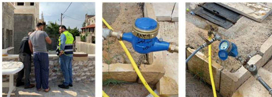
写真 2-3 検針値ゼロメーターの現地訪問、故障メーター、交換後の新規メーター
