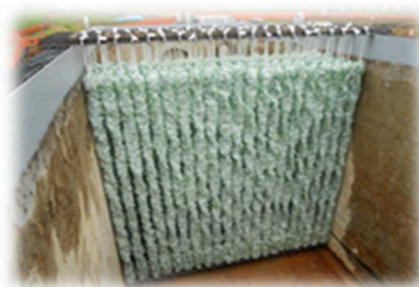
図 2-2 沈澱池への設置例
