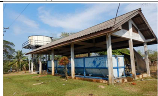
第5回渡航 2020年3月7日 ビエンチャン県 浄水場(装置式)
