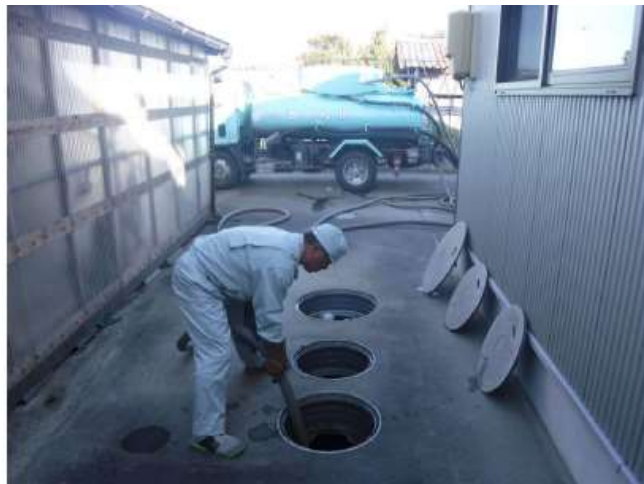
図 32：認定技術者による汚泥除去サービス
