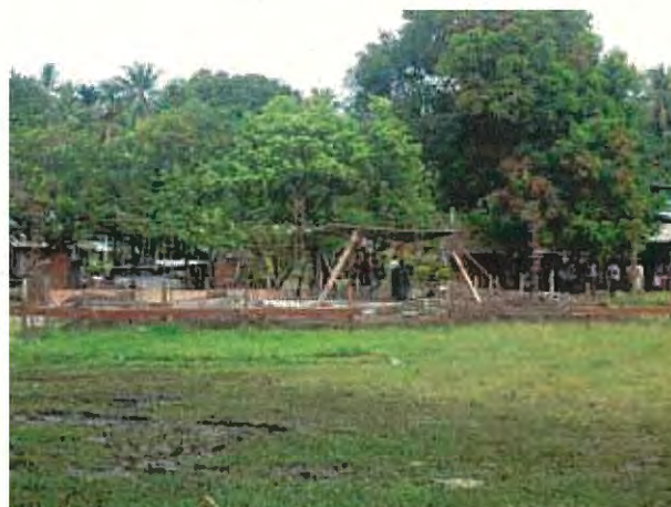
基礎工事が始まっているホール建設現場。
