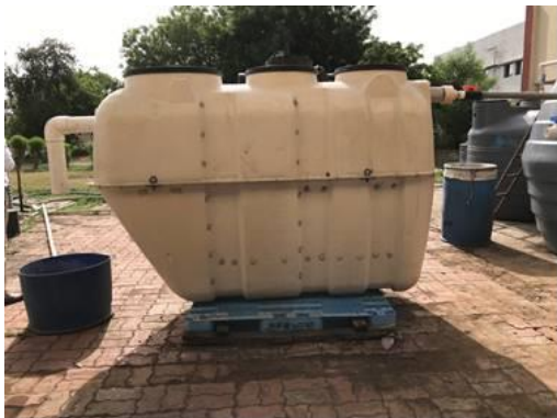
DMR 実験槽設置状況
